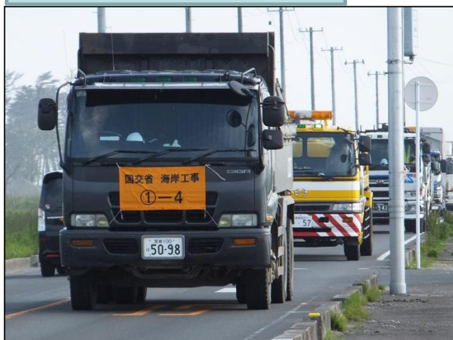
土砂運搬車両 運行状況
