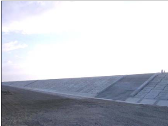
写真 4.1.2-102 付属物設置工 (階段工(陸側)設置完了状況)
