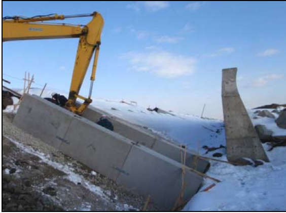
写真 4.1.2-139 付属物設置工 (階段工設置状況)
