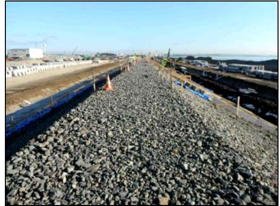
写真 4.1.2-25 護岸工 (天端・法面被覆裏込碎石 (割栗石) 状況)
