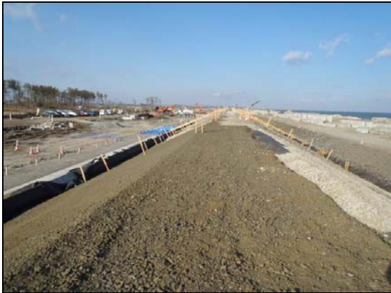
写真 4.1.2-86 護岸工 (裏法被覆裏込砕石(RC-40)状況)
