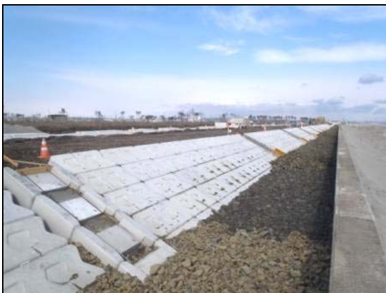
写真 4.1.2-65 付属物設置工 (隔壁工設置施工状況)
