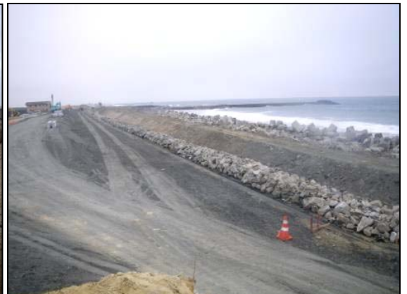
写真 4.1.2-196 護岸基礎工 (海側基礎工状況)
