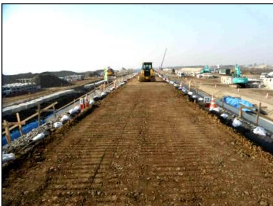
写真 4.1.2-13 海岸土工 (築堤盛土施工状況)
