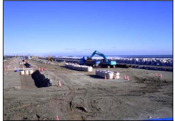
写真 4.1.2-194 地盤改良工 (陸側地盤改良工完了状況)
