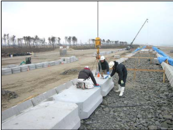
写真 4.1.2-59 護岸工 (天端被覆コンクリートブロック据付状況)
