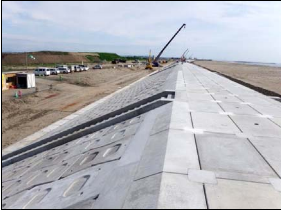
写真 4.1.2-97 護岸工 (裏法面被覆据付完了状況)
