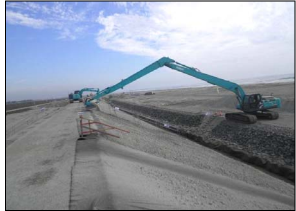
写真 4.1.2-88 護岸工 (表法面被覆裏込砕石(RC-40)施工状況)
