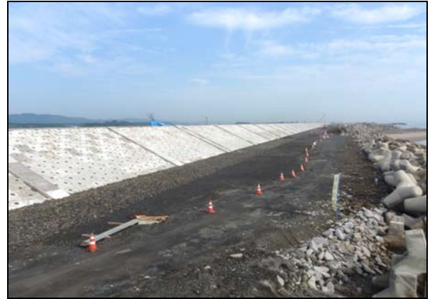
写真 4.1.2-260 護岸工 (表法面被覆据付完了状況)
