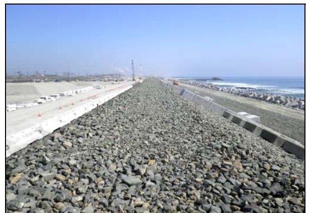
写真 4.1.2-251 護岸工 (天端被覆裏込砕石(割栗石)状況)
