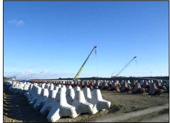
写真 4.1.2-147 消波ブロック工 (消波ブロック工仮置状況)
