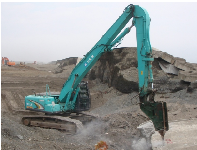
写真 4.1.9-2 大型ブレーカでの取り壊し
