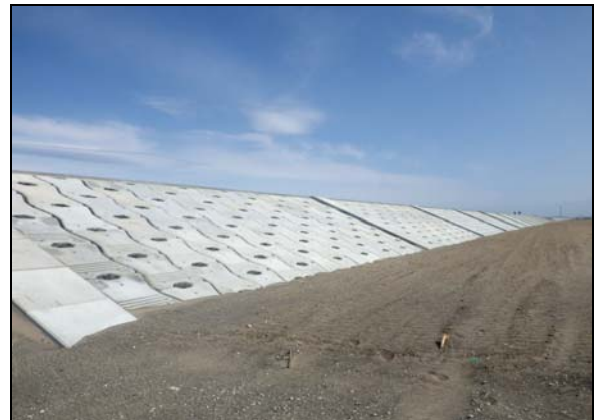
写真 4.1.2-143 付属物設置工 (隔壁工(海側)設置完了状況)
