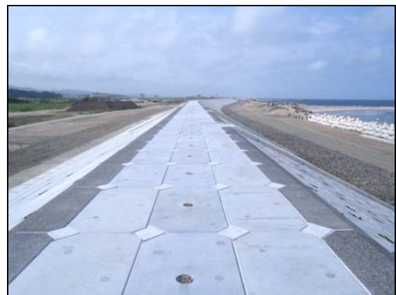
写真 4.1.2-257 護岸工 (天端被覆据付完了状況)
