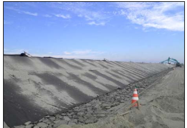
写真 4.1.2-84 護岸工 (表法面被覆吸出し防止材敷設状況)
