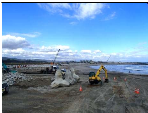
写真 4.1.2-232 仮設工(陸側工事用道路設置状況) 写真 4.1.2-233 仮設工(陸側工事用道路設置完了状況)
