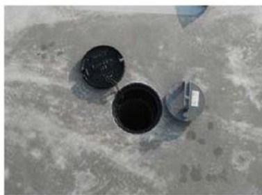
採取孔設置状況
