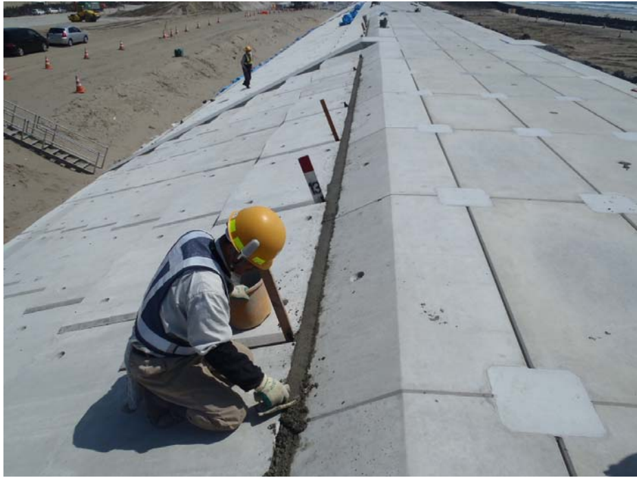
写真 4.1.6-18 陸側端部モルタル設置例
