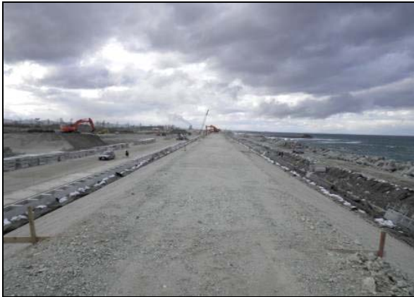
写真 4.1.2-241 護岸土工 (築堤盛土完了状況)
