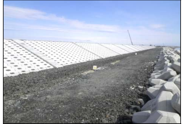
写真 4.1.2-217 護岸工 (表法面被覆据付完了状況)
