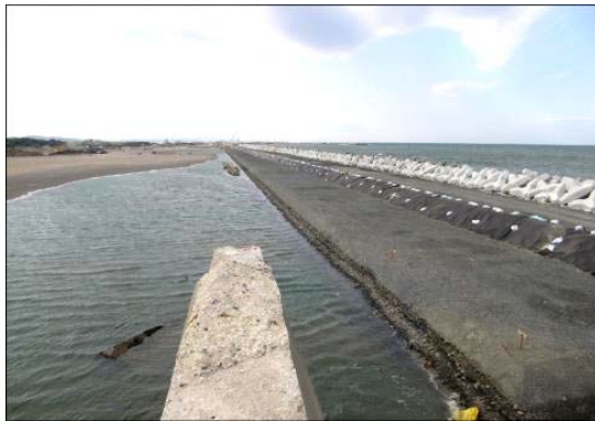
写真 4.1.2-230 仮設工(仮堤防設置状況) 写真 4.1.2-231 仮設工(仮堤防・工事用道路設置状況)
