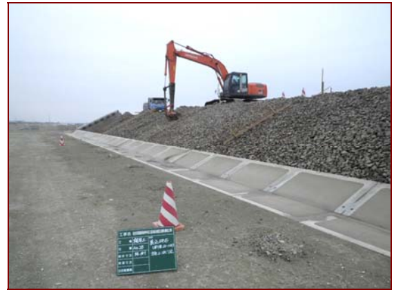
写真 4.1.2-238 護岸基礎工 (陸側護岸基礎工完了)
