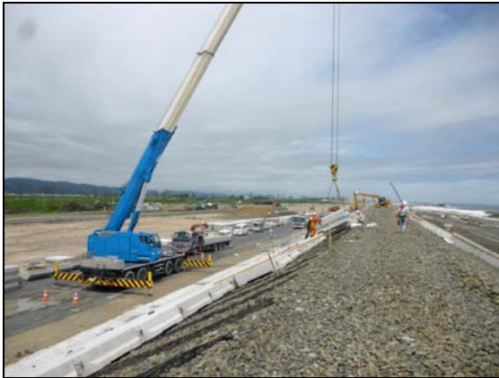
写真 4.1.2-253 護岸工 (裏法被覆コンクリートブロック据付状況)
