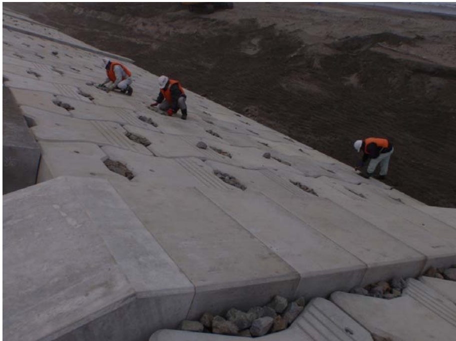
写真 4.1.6-19 間詰め施工例
