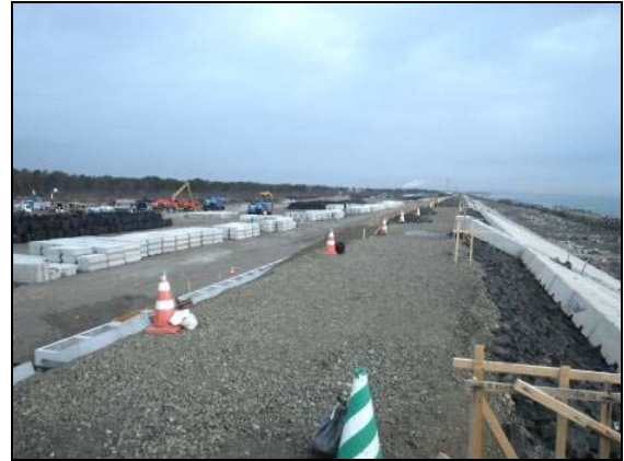
写真 4.1.2-169 護岸工 (天端被覆裏込碎石(RC-40)状況)
