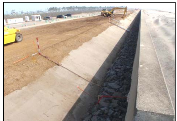
写真 4.1.2-116 護岸基礎工 (海側基礎工状況)
