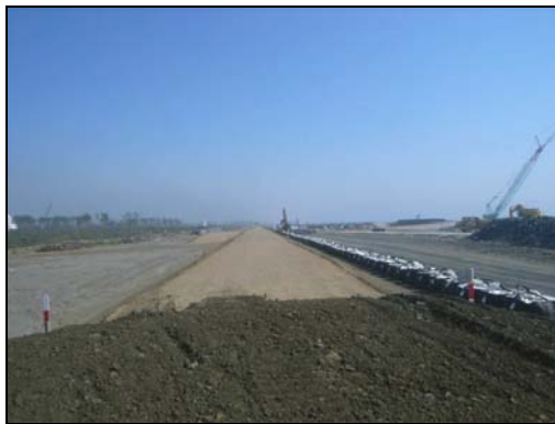
写真4.1.2-109 仮設工(仮堤防設置状況)
