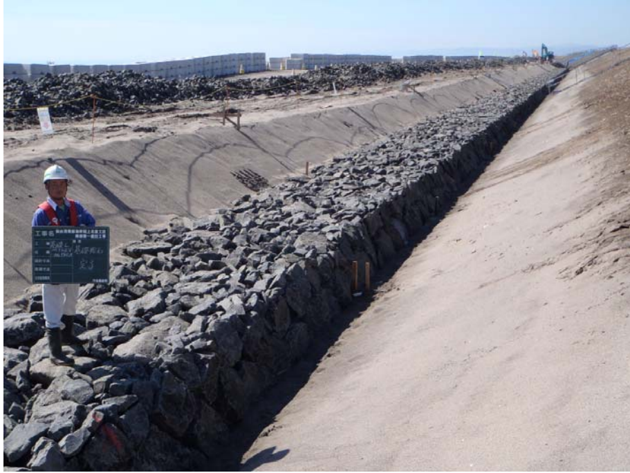
写真 4.1.3-3 基礎捨石施工例
