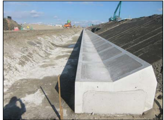
写真 4.1.2-9 護岸基礎工 (陸側護岸基礎工完了状況)
