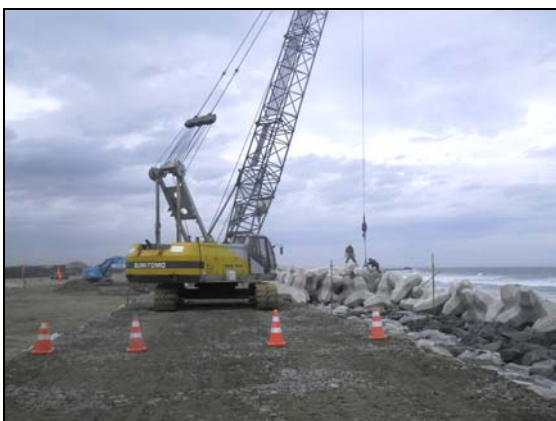
写真 4.1.2-226 消波ブロック工 (消波ブロック工据付状況)
