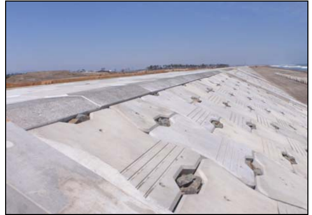
写真 4.1.2-137 護岸工 (表法面被覆据付完了状況)
