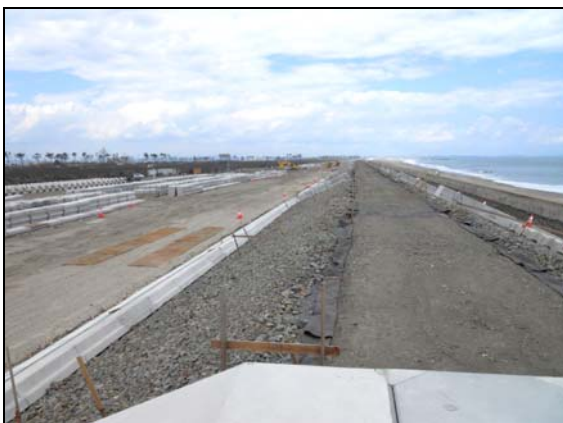
写真 4.1.2-54 護岸工 (裏法面被覆裏込砕石(割栗石)状況)
