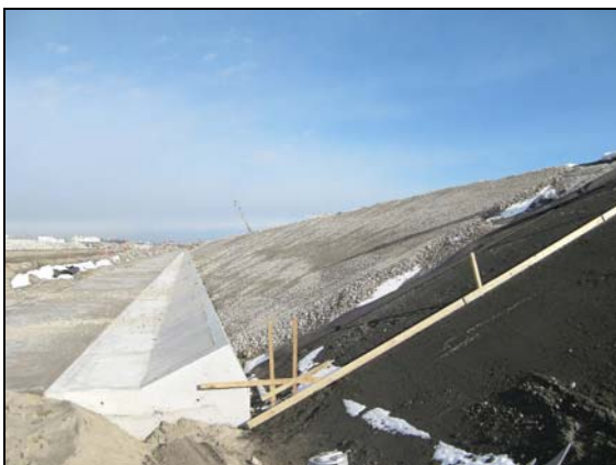
写真 4.1.2-19 護岸工 (裏法面被覆裏込砕石 (RC-40) 状況)
