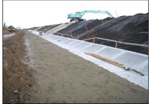
写真 4.1.2-126 護岸工 (法面被覆裏込碎石(RC-40)施工状況)
