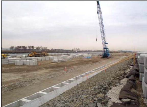
写真 4.1.2-129 護岸工 (裏法面被覆裏込砕石(割栗石)状況)
