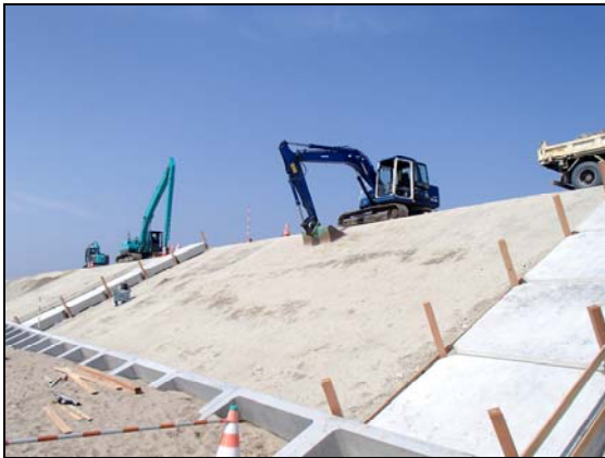
写真 4.1.2-247 護岸工 (裏法被覆裏込砕石(RC-40)状況)
