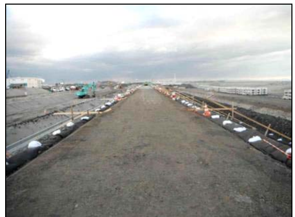
写真 4.1.2-16 海岸土工 (築堤盛土完了状況)
