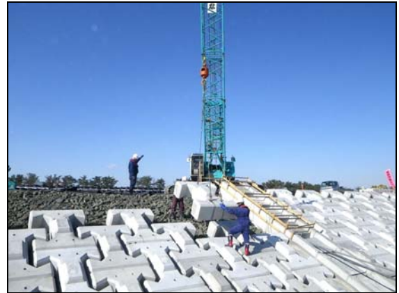
写真 4.1.2-176 護岸工 (表法被覆コンクリートブロック据付状況)
