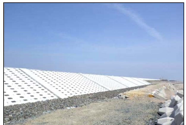
写真 4.1.2-223 付属物設置工 (隔壁工(海側)設置完了状況)
