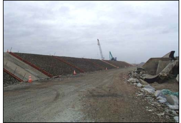
写真 4.1.2-255 護岸工 (表法面被覆裏込砕石(割栗石)状況)
