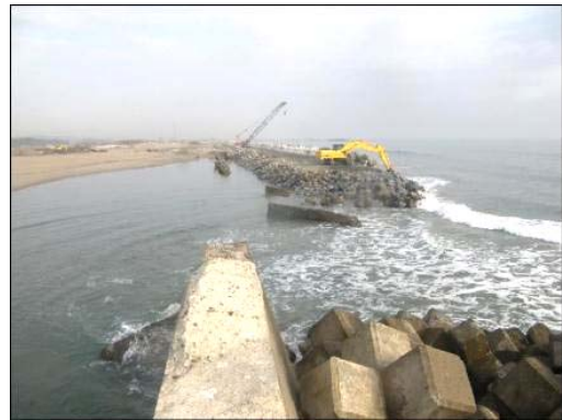
写真 4.1.2-230 仮設工(仮堤防設置状況) 写真 4.1.2-231 仮設工(仮堤防・工事用道路設置状況)
