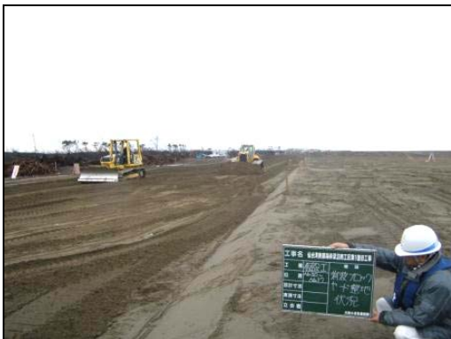
写真 4.1.2-39仮設工（作業ヤード施工状況）
