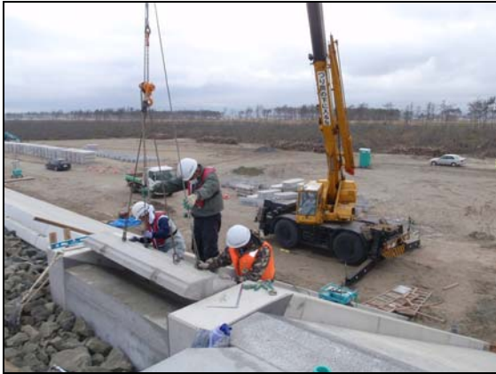
写真 4.1.2-64 付属物設置工 (階段工設置施工状況)
