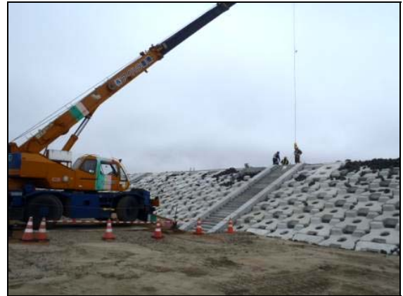
写真 4.1.2-37 付属物設置工 (階段工設置施工状況)
