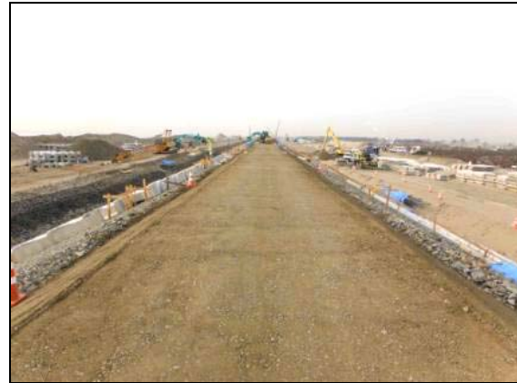
写真 4.1.2-21 護岸工 (天端・法面被覆裏込砕石 (RC-40) 状況)
