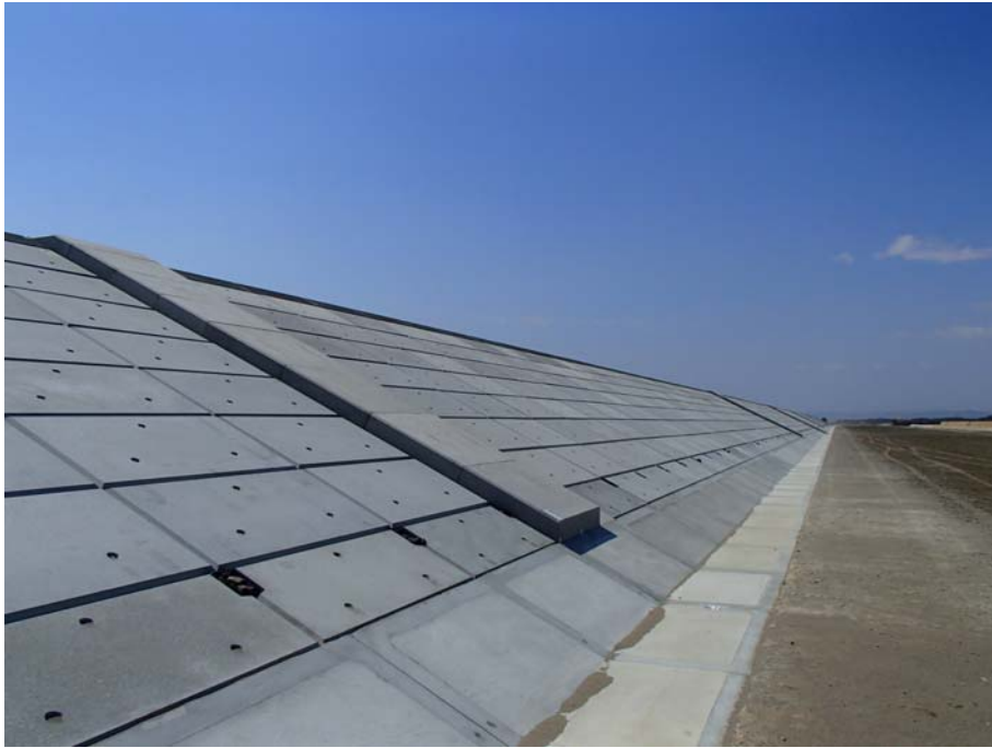
写真 4.1.6-5 陸側被覆ブロック施工例(割付間隔 10mm 以下)
