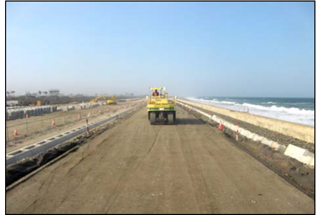
写真 4.1.2-50 海岸土工 (築堤盛土工状況)
