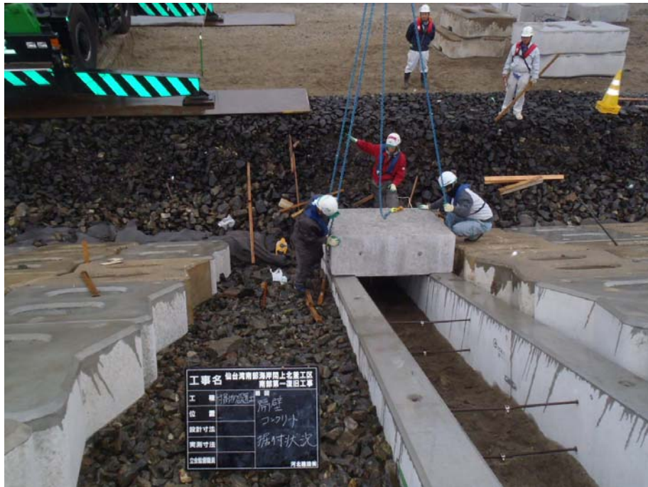
写真 4.1.6-13 調整コンクリート施工の例
