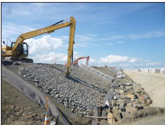
写真 4.1.2-248 護岸工 (法面被覆裏込砕石(割栗石)状況)
