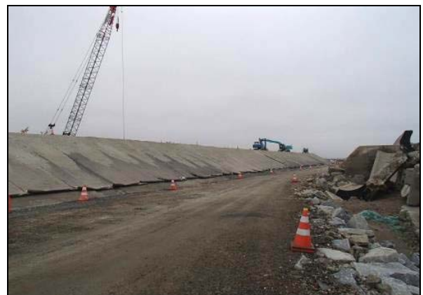
写真 4.1.2-245 護岸工 (表法面被覆吸出し防止材敷設状況)
