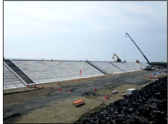
写真 4.1.2-184 付属物設置工 (階段工(海側)設置完了状況)
