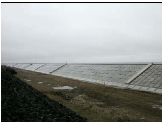
写真 4.1.2-183 付属物設置工 (隔壁工(陸側)設置完了状況)
