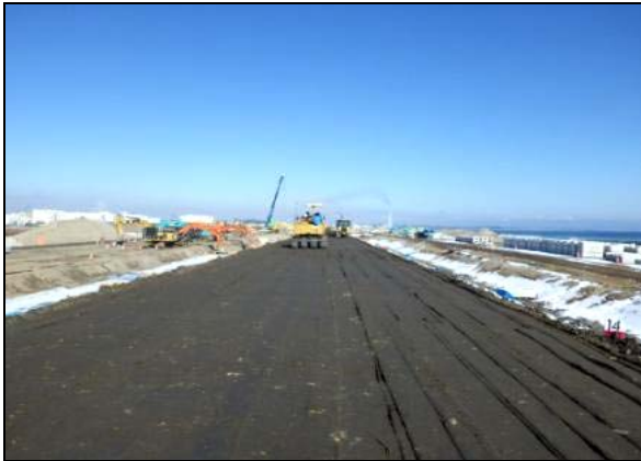
写真 4.1.2-12 海岸土工 (築堤盛土施工状況)
