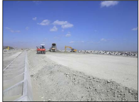
写真 4.1.2-243 海岸土工 (築堤盛土施工状況)
