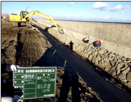
写真 4.1.2-43 護岸基礎工 (海側護岸基礎工施工状況)
