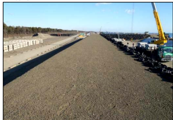
写真 4.1.2-151 仮設工(仮堤防設置完了状況)
