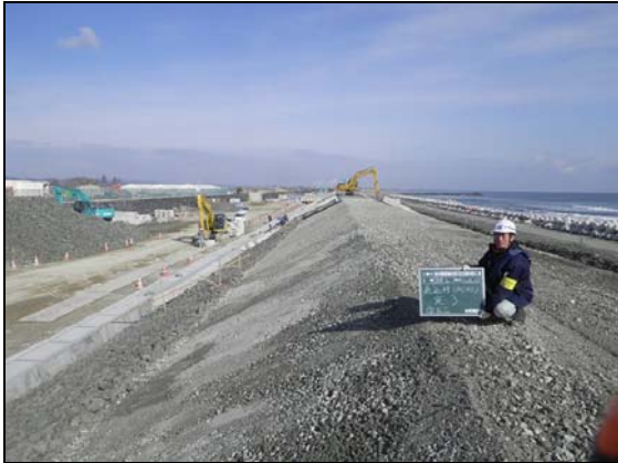
写真 4.1.2-204 護岸工 (裏法被覆裏込砕石(RC-40)状況)
