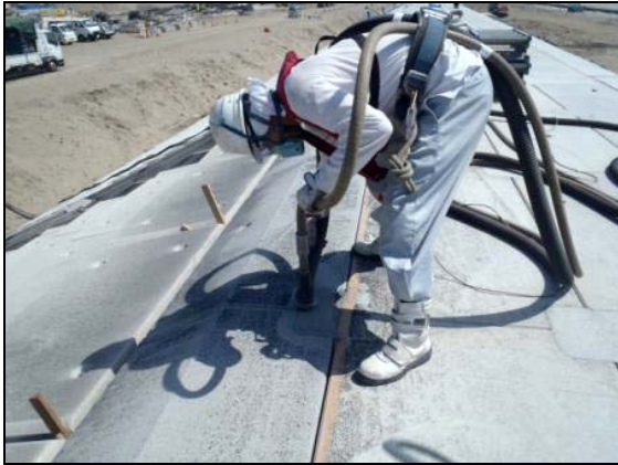
写真 4.1.2-33 護岸工 (天端被覆洗出し処理状況)
