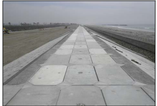
写真 4.1.2-62 護岸工 (天端被覆据コンクリートブロック付完了状況)
