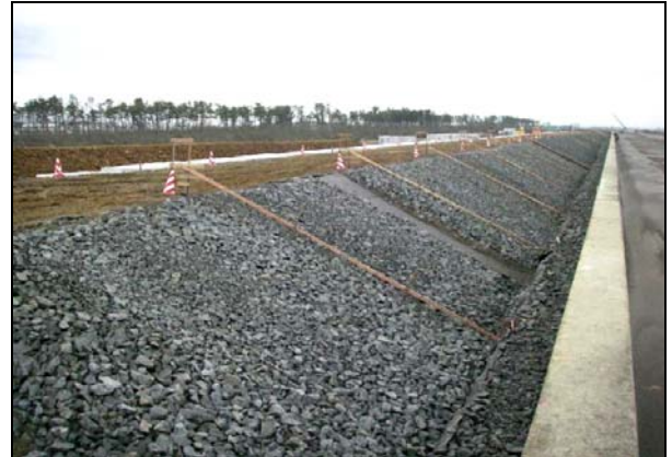
写真 4.1.2-132 護岸工 (表法面被覆裏込砕石(割栗石)状況)
