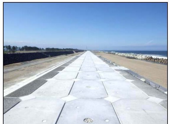
写真 4.1.2-177 護岸工 (天端被覆据付完了状況)
