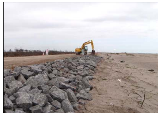
写真 4.1.2-72 仮設工(仮堤防設置状況) 写真 4.1.2-73 仮設工(仮堤防工設置完了状況)
