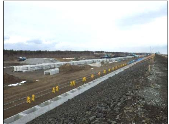
写真 4.1.2-158 護岸基礎工 (陸側護岸基礎工完了)
