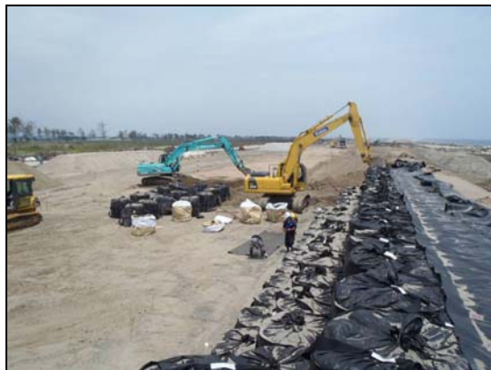
写真4.1.2-70 仮設工(緊急復旧堤防撤去状況) 写真4.1.2-71 仮設工(緊急復旧堤防撤去状況)
