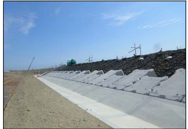
写真 4.1.2-78 護岸基礎工 (陸側護岸基礎工完了)
