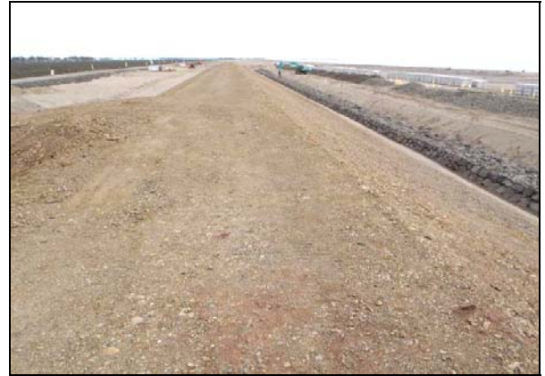
写真 4.1.2-82 海岸土工 (築堤盛土完了状況)
