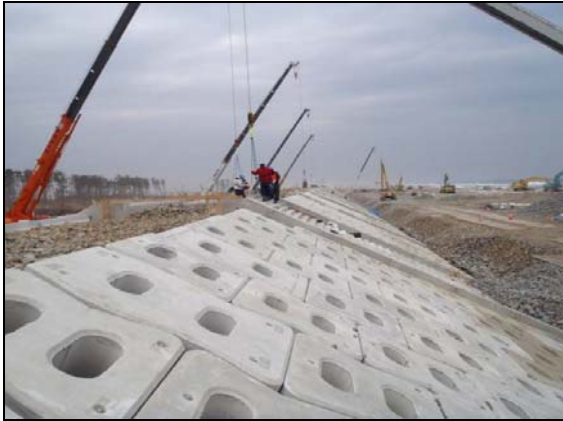
写真 4.1.2-101 付属物設置工 (階段工設置状況)
