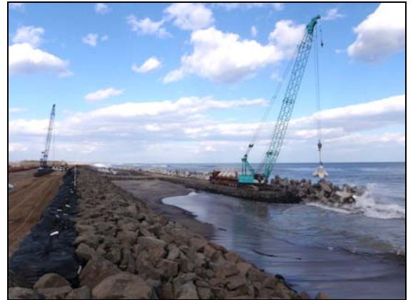
写真 4.1.2-148 消波ブロック工 (消波ブロック工据付状況)
