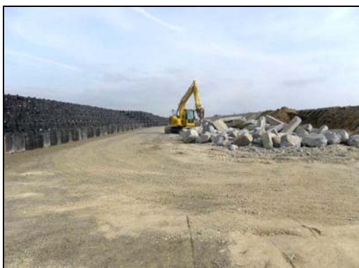
写真 4.1.2-189 構造物撤去工 （既設堤防撤去状況）
