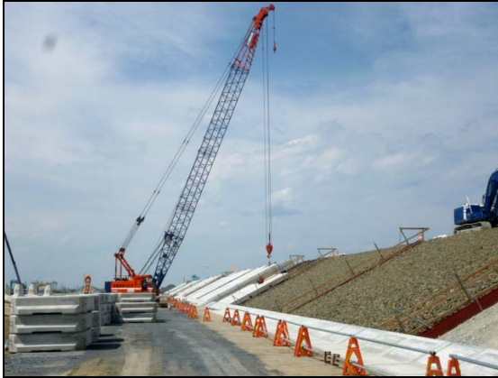
写真 4.1.2-252 護岸工 (裏法面被覆裏込砕石(割栗石)状況)
