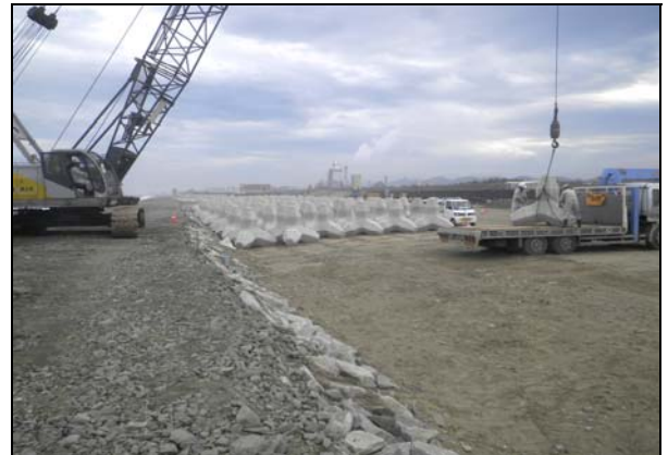
写真 4.1.2-228 消波ブロック工 (消波ブロック工運搬・荷卸状況)
