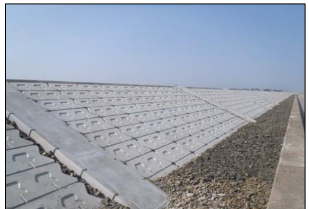
写真 4.1.2-63 護岸工 (表法面被覆据コンクリートブロック付完了状況)
