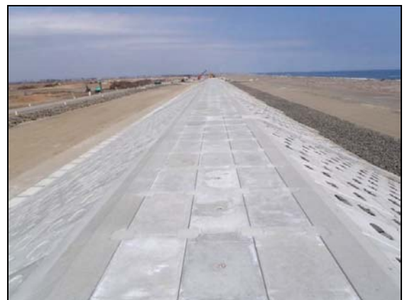
写真 4.1.2-96 護岸工 (天端被覆据付完了状況)
