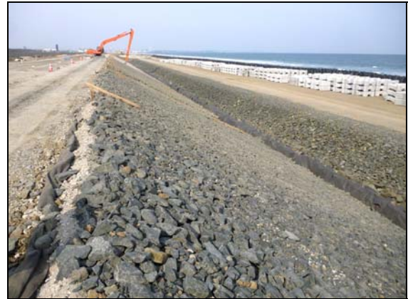
写真 4.1.2-26 護岸工 (表法面被覆裏込碎石 (割栗石) 状況)
