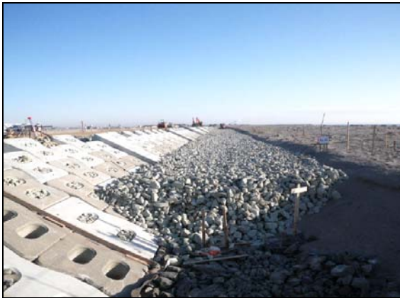
写真 4.1.2-98 表法尻保護工 (基礎割栗石敷設状況)
