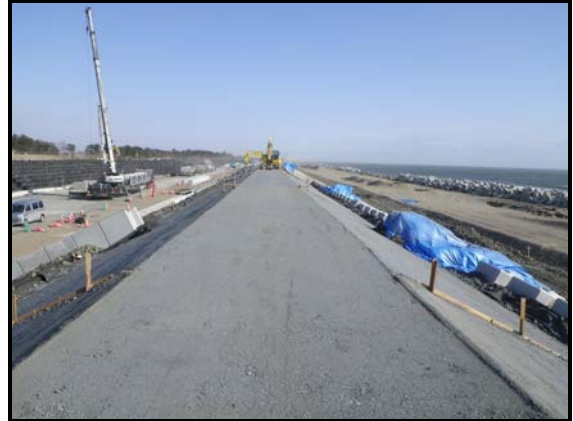
写真 4.1.2-163 海岸土工 (築堤盛土完了状況)
