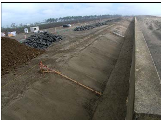
写真 4.1.2-113 護岸基礎工 (海側護岸基礎工床付け状況)
