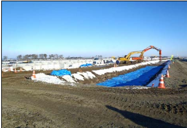
写真 4.1.2-111 地盤改良工 (陸側地盤改良工施工状況)
