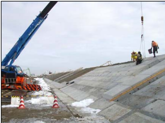
写真 4.1.2-130 護岸工 (裏法被覆コンクリートブロック据付状況)
