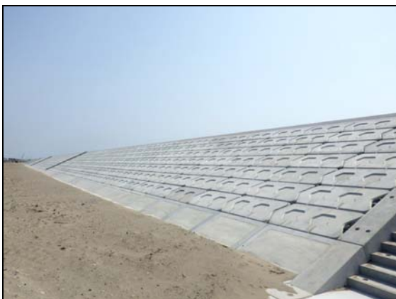
写真 4.1.2-60 護岸工 (裏法面被覆据コンクリートブロック付完了状況)
