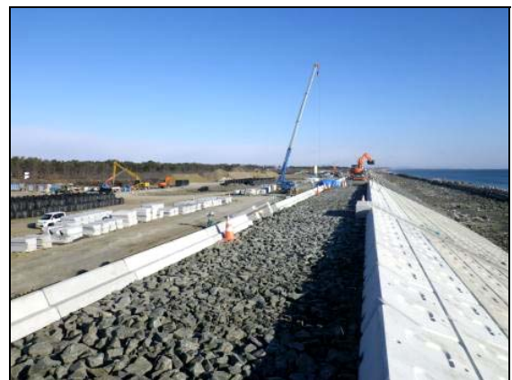
写真 4.1.2-171 護岸工 (天端被覆裏込碎石(割栗石)状況)
