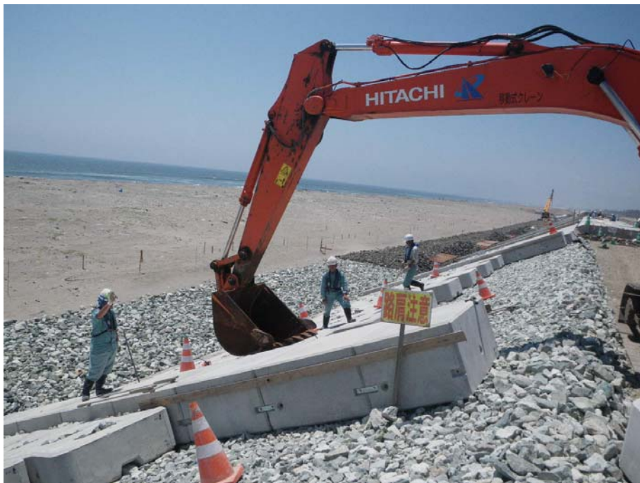
写真 4.1.6-14 隔壁工(海側)施工の例
