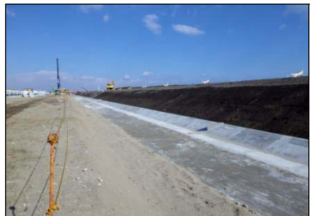
写真 4.1.2-10 地盤改良工・護岸基礎工 (陸側完了状況)
