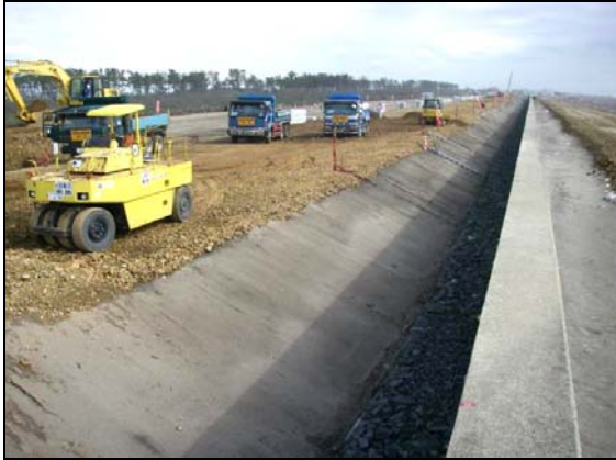
写真 4.1.2-117 海岸土工 (築堤盛土施工状況)
