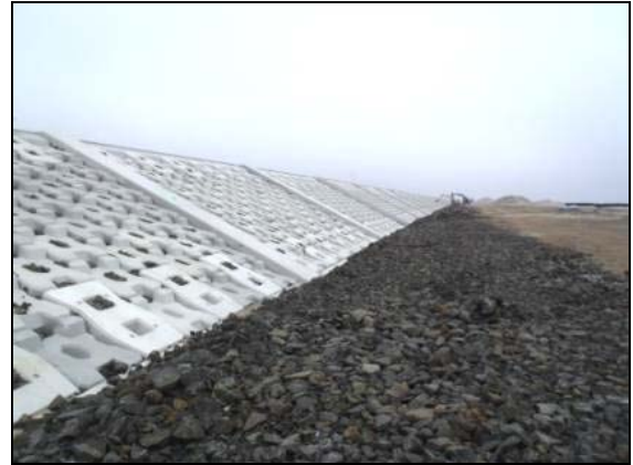
写真 4.1.2-36 表法尻保護工 (基礎割栗石敷設状況)
