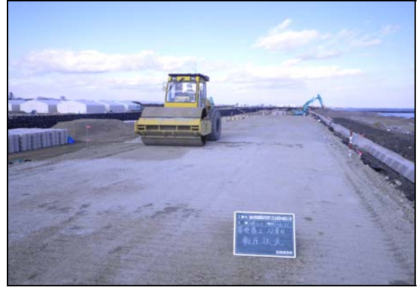
写真 4.1.2-200 海岸土工 (築堤盛土状況)
