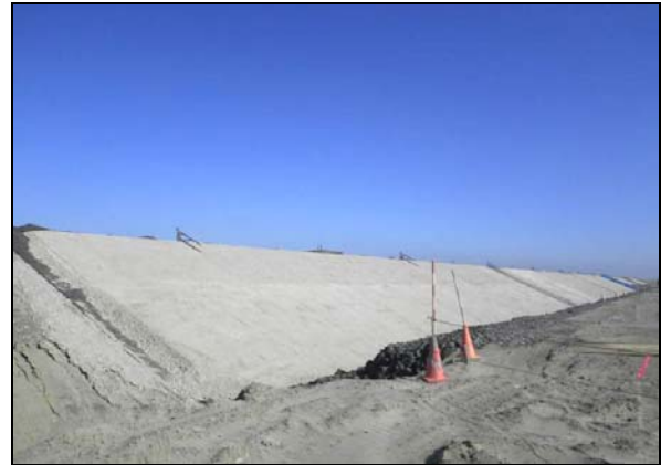
写真 4.1.2-89 護岸工 (表法被覆裏込砕石(RC-40)状況)
