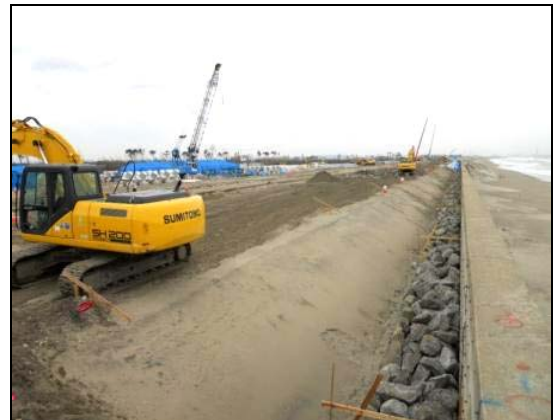
写真 4.1.2-46 護岸基礎工 (海側基礎工状況)
