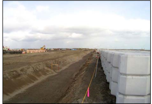
写真 4.1.2-77 地盤改良工 (陸側地盤改良工完了状況)
