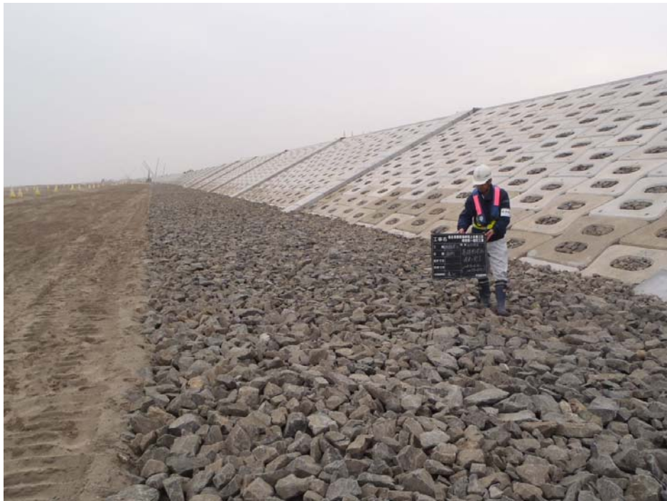
写真 4.1.3-5 法尻保護施工例
