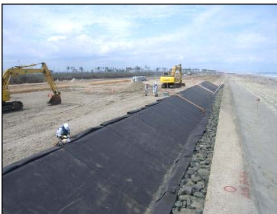
写真 4.1.2-49 護岸工 (法面被覆吸出し防止材状況)
