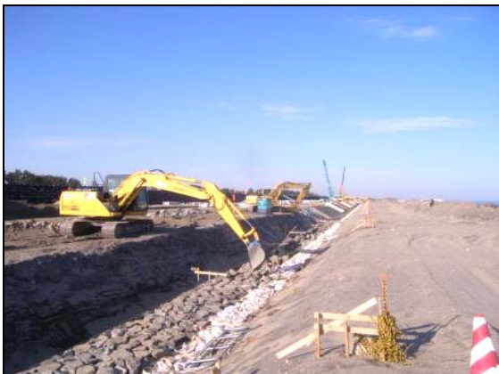
写真 4.1.2-156 護岸基礎工 (海側護岸基礎工施工状況)
