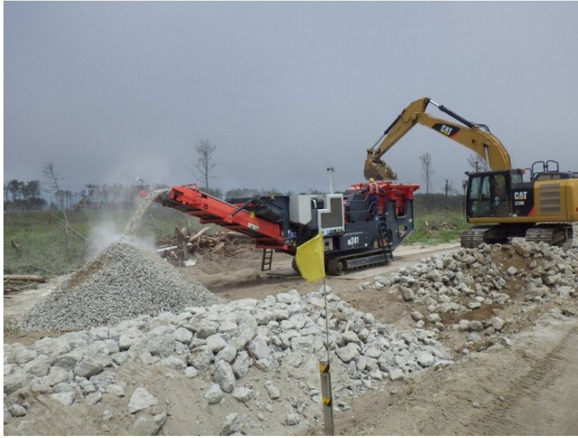
写真 4.1.9-4 自走式破碎機の稼働状況
