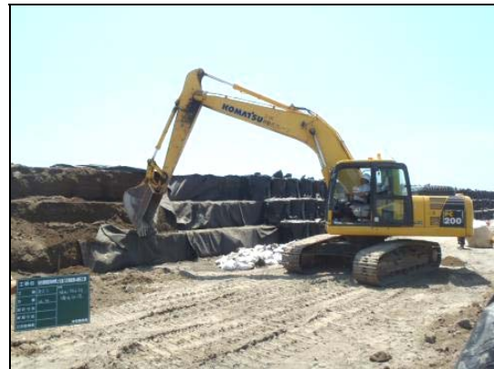
写真4.1.2-70 仮設工(緊急復旧堤防撤去状況) 写真4.1.2-71 仮設工(緊急復旧堤防撤去状況)
