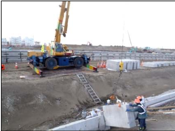
写真 4.1.2-34 付属物設置工 (階段工設置施工状況)
