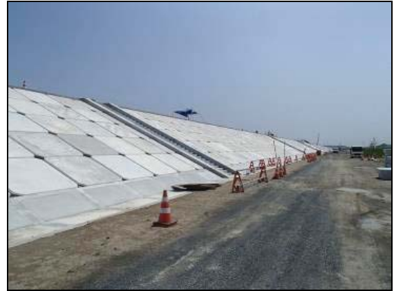
写真 4.1.2-264 付属物設置工 (階段工(陸側)設置完了状況)
