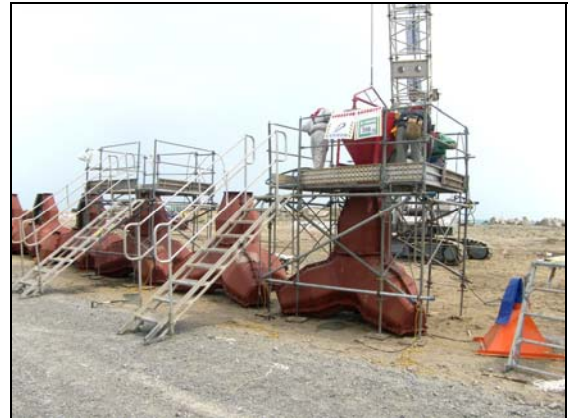
写真 4.1.2-269 消波ブロック工 (消波ブロック工据付状況)
