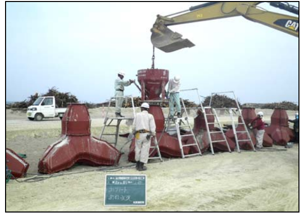
写真 4.1.2-227 消波ブロック工 (消波ブロック工製作状況)
