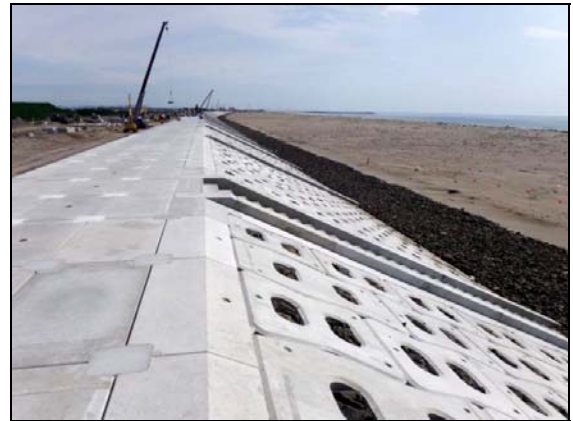
写真 4.1.2-100 表法尻保護工 (基礎割栗石敷設状況)
