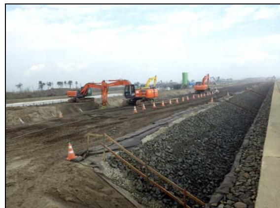
写真 4.1.2-57 護岸工 (表法面被覆裏込砕石(割栗石)状況)
