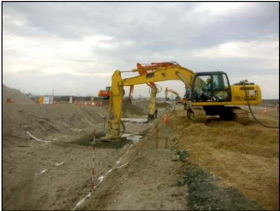
写真 4.1.2-6 護岸基礎工 (陸側護岸基礎工施工状況)
