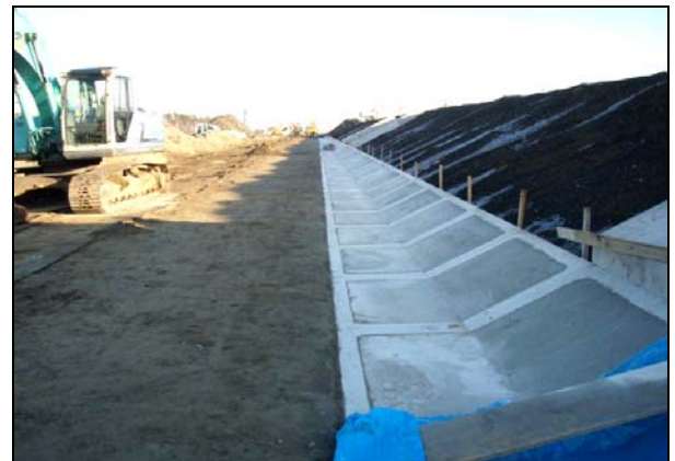
写真 4.1.2-115 護岸基礎工 (陸側護岸基礎工完了)
