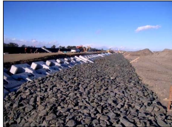
写真 4.1.2-181 表法尻保護工 (基礎割栗石敷設状況)
