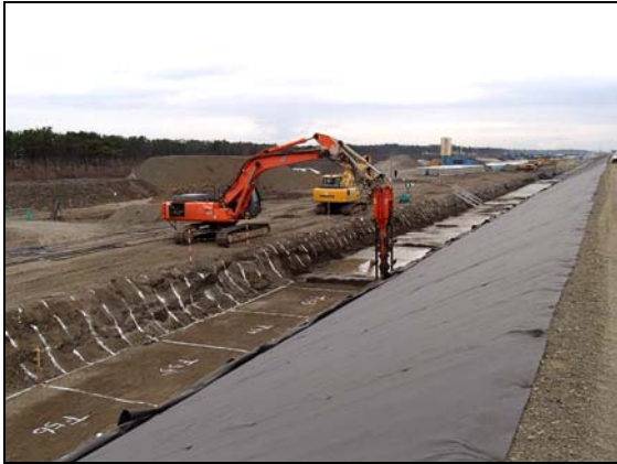
写真 4.1.2-154 地盤改良工 (陸側地盤改良工 1 層目状況)
