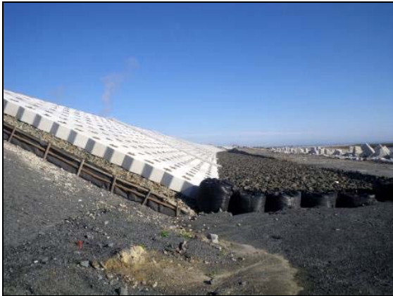
写真 4.1.2-216 表法尻保護工 (基礎割栗石敷設状況)
