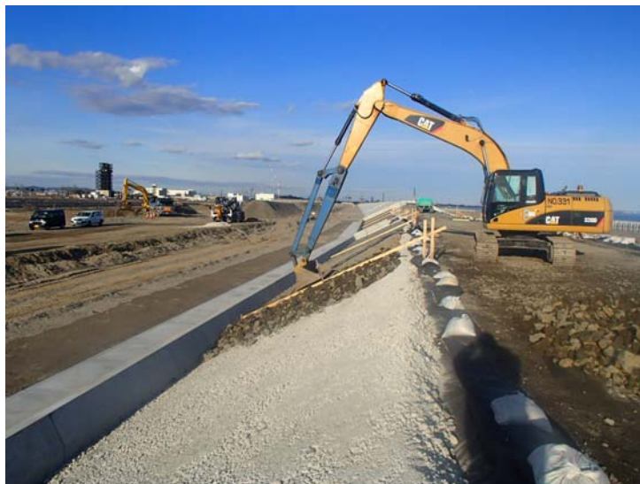
写真4.1.6-3 裏込碎石施工例
