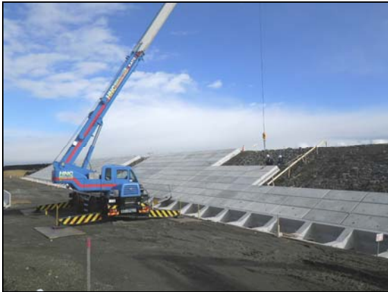
写真 4.1.2-173 護岸工 (裏法被覆コンクリートブロック据付状況)
