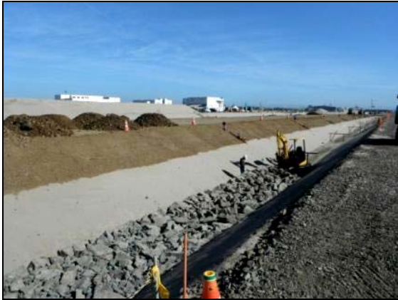
写真 4.1.2-11 護岸基礎工 (海側護岸基礎工施工状況)
