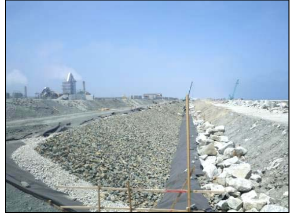
写真 4.1.2-212 護岸工 (表法面被覆裏込砕石(割栗石)状況)
