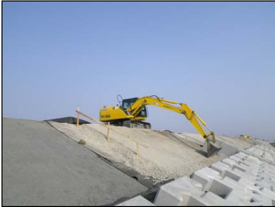
写真 4.1.2-166 護岸工 (法面被覆裏込碎石(RC-40)施工状況)
