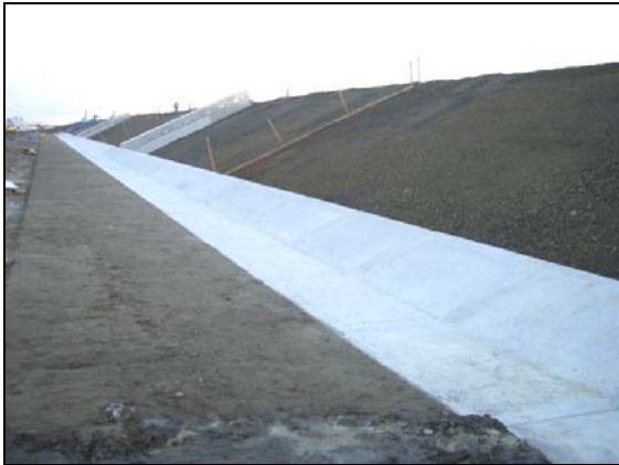
写真 4.1.2-124 護岸工 (裏法被覆裏込碎石(RC-40)状況)
