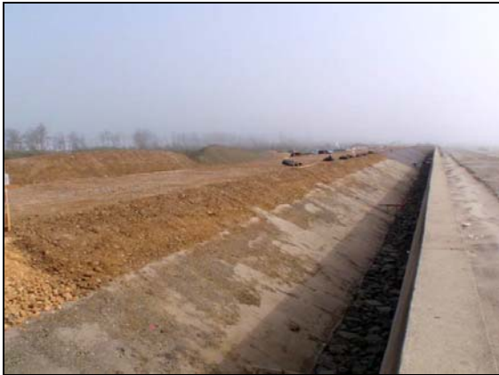
写真 4.1.2-118 護岸工 (表法面被覆吸出し防止材敷設施工状況)
