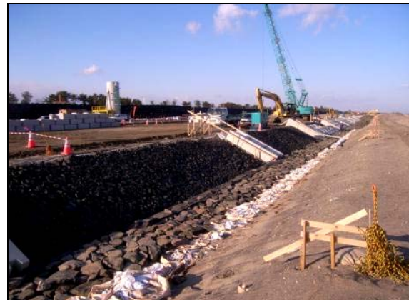
写真 4.1.2-159 護岸基礎工 (海側基礎工状況)
