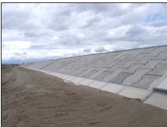
写真 4.1.2-66 付属物設置工 (陸側隔壁工設置完了状況)
