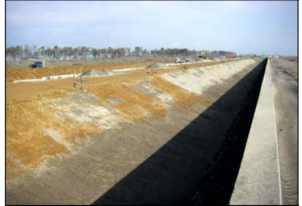
写真 4.1.2-120 海岸土工 (築堤盛土完了状況)
