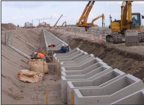
写真 4.1.2-75 護岸基礎工 (陸側護岸基礎工施工状況)
