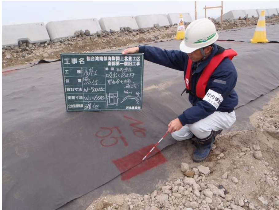
写真 4.1.6-1 吸出し防止材の重ね合わせ例(陸側より望む)
