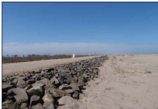
写真 4.1.2-72 仮設工(仮堤防設置状況) 写真 4.1.2-73 仮設工(仮堤防工設置完了状況)
