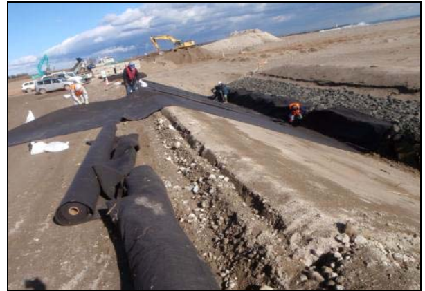
写真 4.1.2-83 護岸工 (表法面被覆吸出し防止材敷設施工状況)
