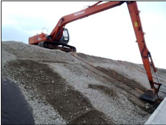
写真 4.1.2-18 護岸工 (法面被覆裏込砕石 (RC-40) 状況)
