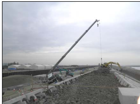
写真 4.1.2-208 護岸工 (天端被覆裏込砕石(割栗石)状況)
