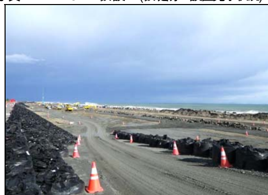
写真 4.1.2-153 構造物撤去工(既設堤防撤去完了状況)
