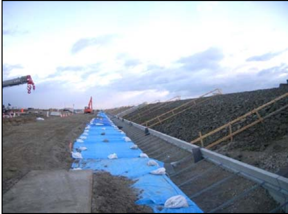
写真 4.1.2-91 護岸工 (裏法面被覆裏込砕石(割栗石)状況)
