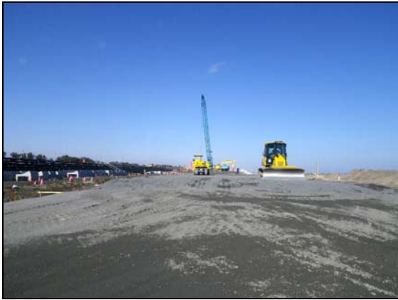
写真 4.1.2-160 海岸土工 (築堤盛土施工状況)
