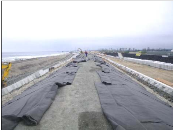
写真 4.1.2-198 護岸工 (法面・天端被覆吸出し防止材敷設状況)
