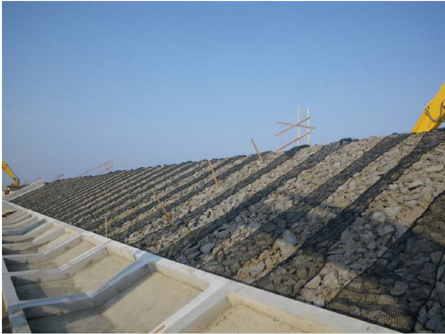
写真 4.1.6-7 吸出し防止ネット施工例(5cm 以上開口部処理)
