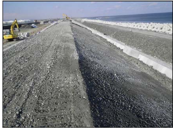
写真 4.1.2-207 護岸工 (表法被覆裏込砕石(RC-40)状況)
