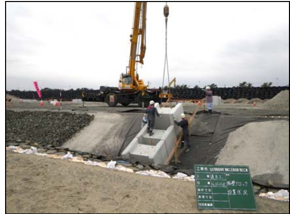
写真 4.1.2-185 付属物設置工 (隔壁工設置状況)
