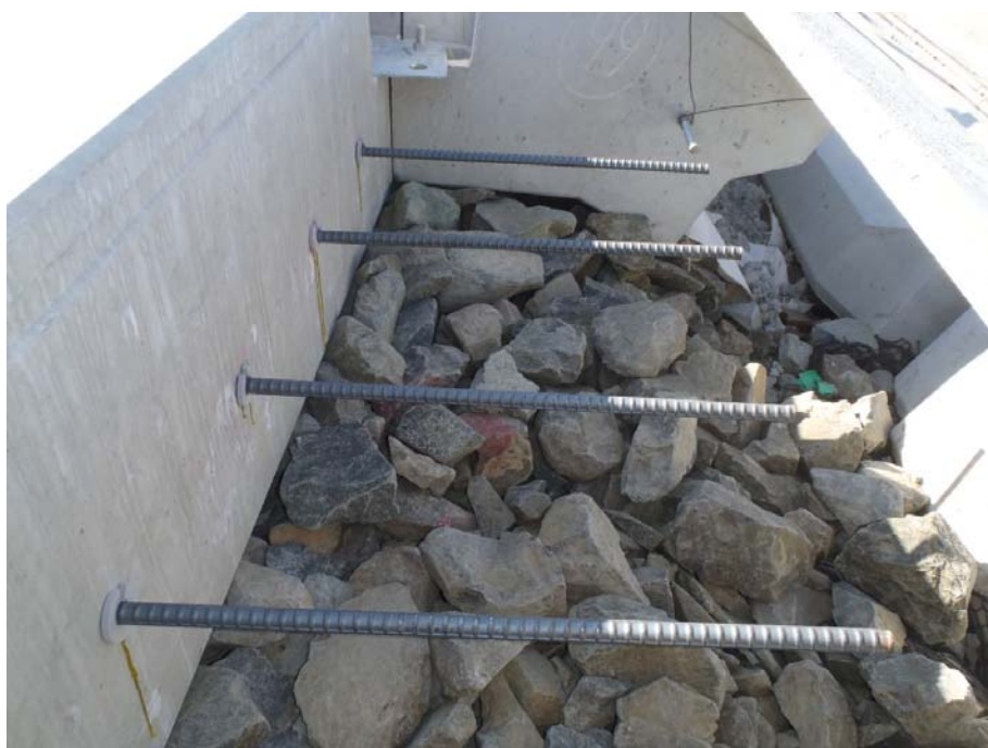
写真 4.1.7-6 法肩部現場打ち施工の例②
