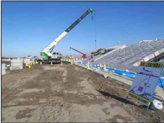
写真 4.1.2-92 護岸工 (裏法被覆コンクリートブロック据付状況)
