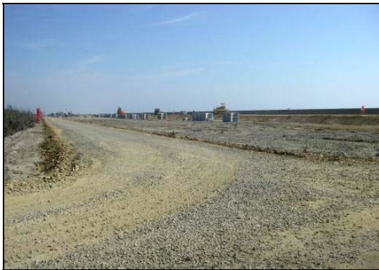
写真 4.1.2-107 仮設工(工事用道路設置状況)
