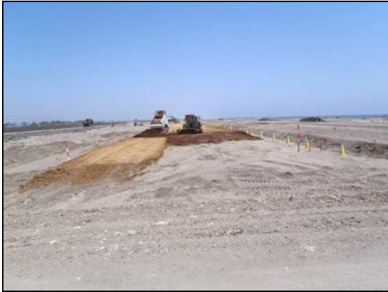
写真 4.1.2-80 海岸土工 (築堤盛土施工状況)
