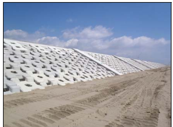
写真 4.1.2-32 護岸工 (表法面被覆コンクリートブロック据付完了状況)
