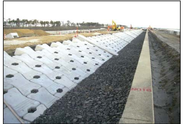
写真 4.1.2-138 表法尻保護工 (基礎割栗石敷設状況)
