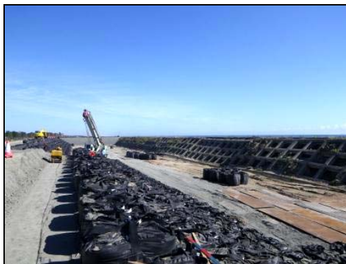
写真 4.1.2-150 仮設工(仮堤防設置状況)
