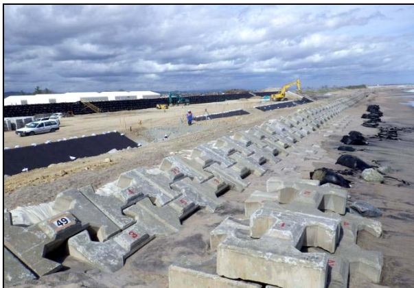
写真 4.1.2-199 護岸工 (裏法面被覆吸出し防止材敷設状況)
