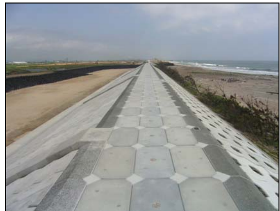
写真 4.1.2-214 護岸工 (天端被覆据付完了状況)
