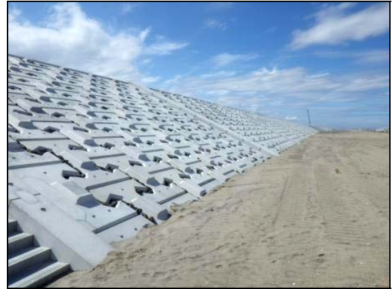
写真 4.1.2-180 護岸工 (表法面被覆据付完了状況)
