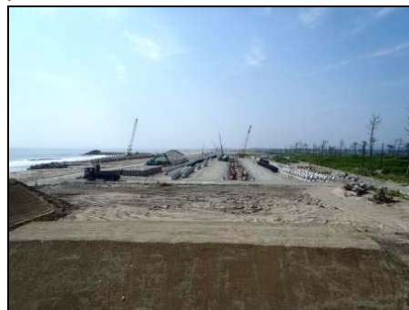
写真 4.1.2-188 仮設工 （作業ヤード・ストックヤード状況）
