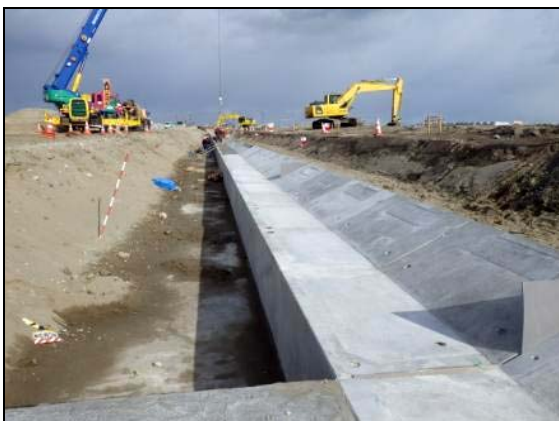
写真 4.1.2-7 地盤改良工 (陸側地盤改良基礎工 2 層目施工状況)
