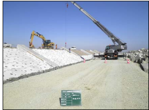
写真 4.1.2-256 護岸工 (表法被覆コンクリートブロック据付状況)
