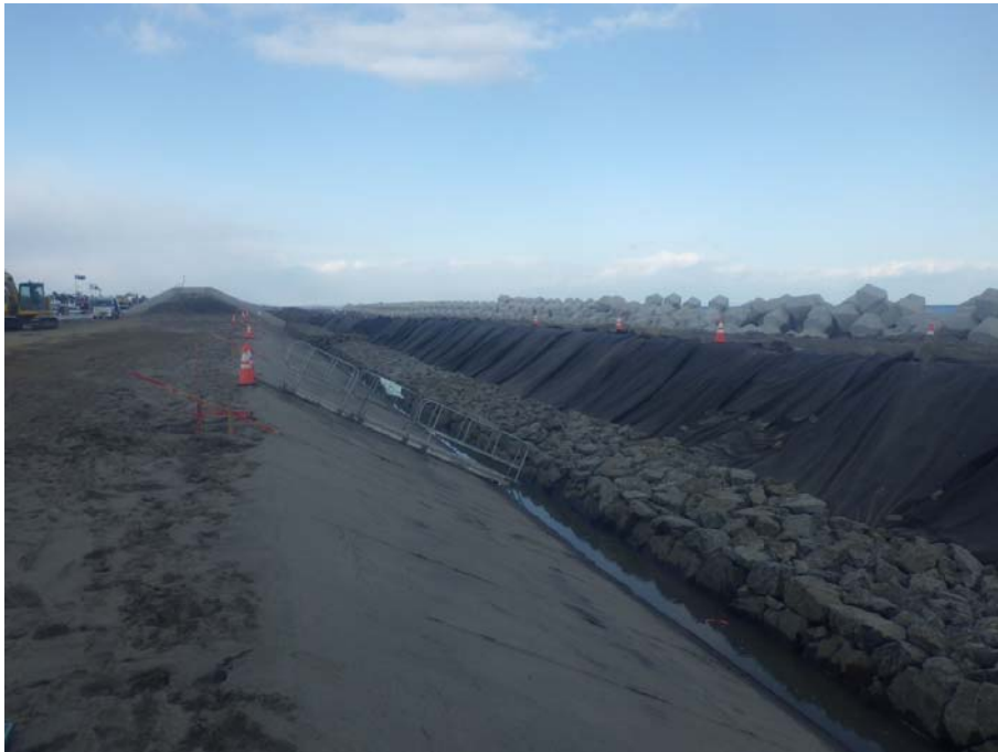
写真 4.1.3-4 吸出し防止材施工例
