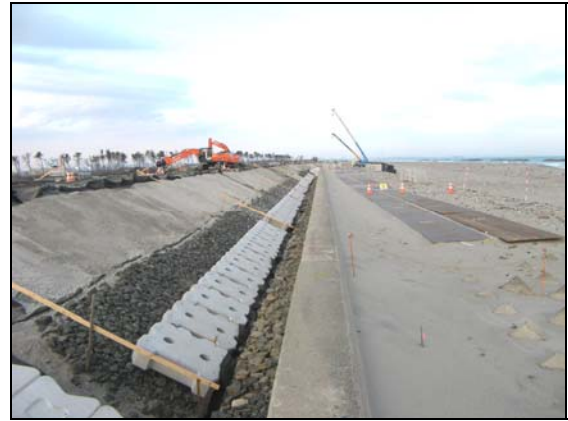
写真 4.1.2-55 護岸工 (法面被覆裏込砕石 (RC-40) 状況)
