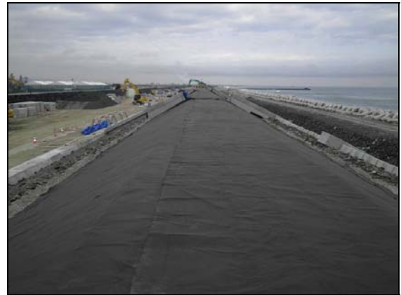
写真 4.1.2-201 護岸工 (天端被覆吸出し防止材敷設状況)
