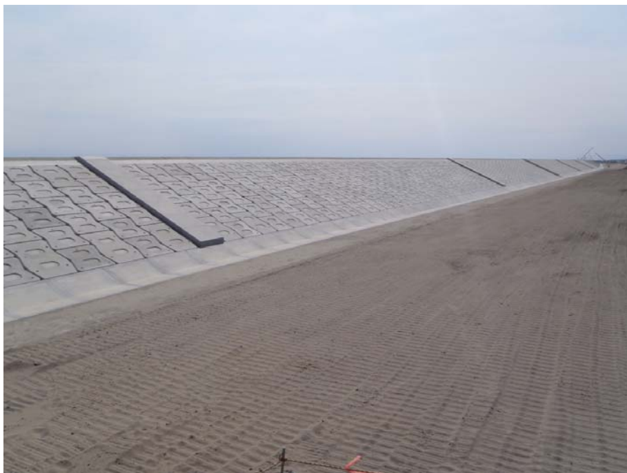
写真 4.1.6-12 隔壁工(陸側)の設置状況
