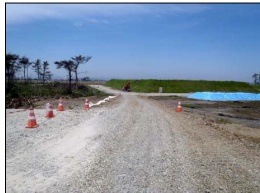
写真 4.1.2-40仮設工（仮設道路完了状況）
