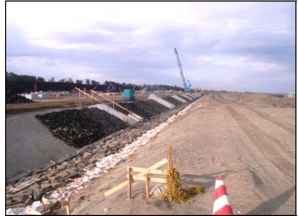
写真 4.1.2-175 護岸工 (表法面被覆裏込砕石(割栗石)状況)
