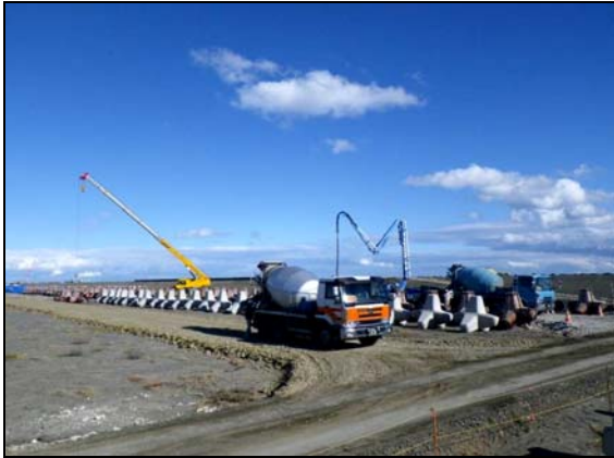
写真 4.1.2-144 消波ブロック工 (消波ブロック工製作状況)
