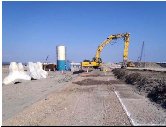
写真 4.1.2-234 地盤改良工 (陸側地盤改良工施工状況)
