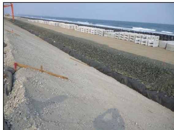
写真 4.1.2-22 護岸工 (表法面被覆裏込砕石 (RC-40) 状況)
