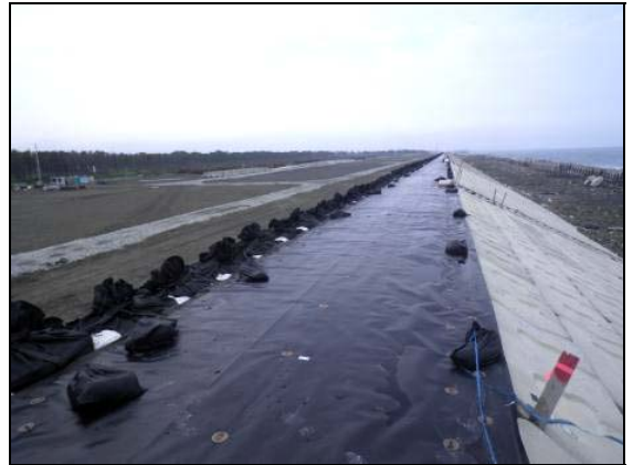
写真 4.1.2-164 護岸工 (天端被覆吸出し防止材敷設状況)
