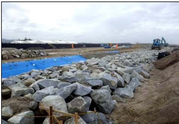
写真 4.1.2-193 護岸基礎工 (海側護岸基礎工施工状況)
