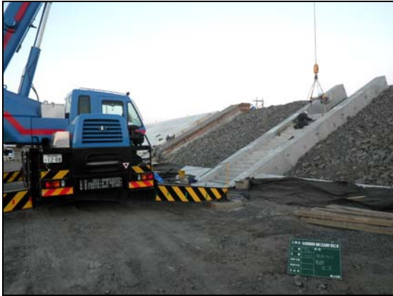
写真 4.1.2-182 付属物設置工 (階段工設置状況)
