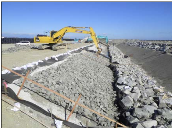
写真 4.1.2-205 護岸工 (法面被覆裏込砕石(割栗石)状況)
