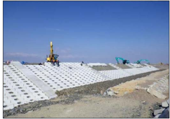
写真 4.1.2-213 護岸工 (表法被覆コンクリートブロック据付状況)
