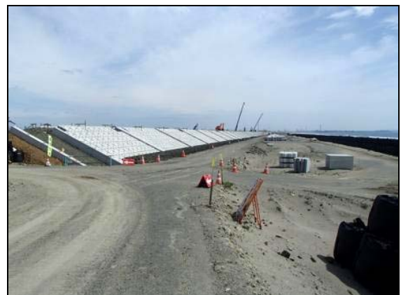
写真 4.1.2-38 付属物設置工 (隔壁工設置完了状況)
