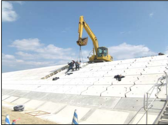
写真 4.1.2-210 護岸工 (裏法被覆コンクリートブロック据付状況)
