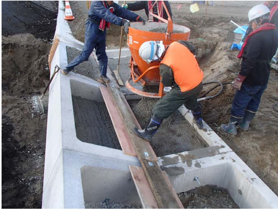
写真 4.1.3-2 中詰コンクリートの打設処理状況
