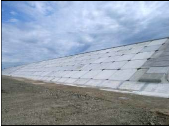
写真 4.1.2-258 護岸工 (裏法面被覆据付完了状況)
