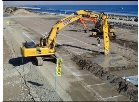
写真 4.1.2-237 地盤改良工 (陸側地盤改良工状況)
