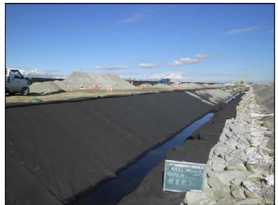
写真 4.1.2-202 護岸工 (表法面被覆吸出し防止材敷設状況)
