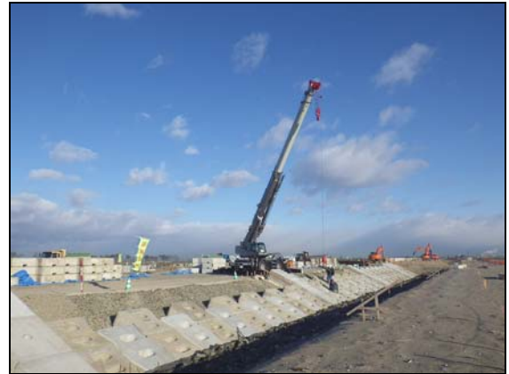
写真 4.1.2-95 護岸工 (表法被覆コンクリートブロック据付状況)
