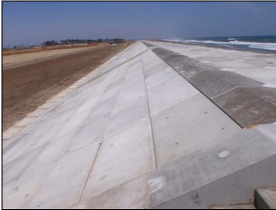
写真 4.1.2-135 護岸工 (裏法面被覆据付完了状況)
