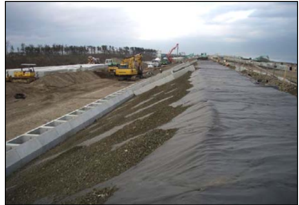
写真 4.1.2-121 護岸工 (天端被覆吸出し防止材敷設状況)
