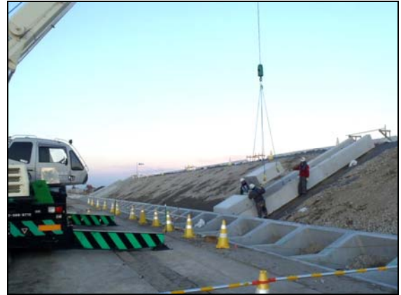
写真 4.1.2-104 付属物設置工 (隔壁工設置施工状況)
