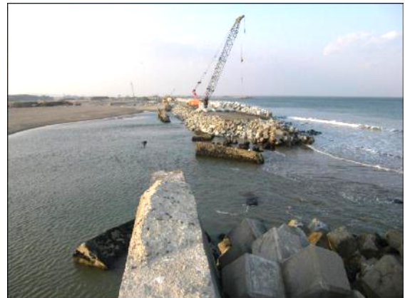
写真 4.1.2-270 消波ブロック工 (消波ブロック工据付状況)
