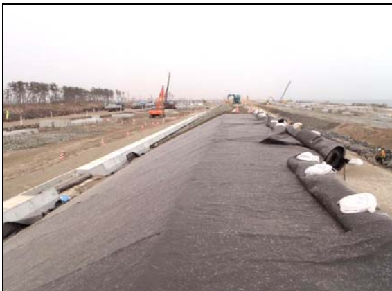
写真 4.1.2-81 護岸工 (裏法面被覆吸出し防止材敷設状況)
