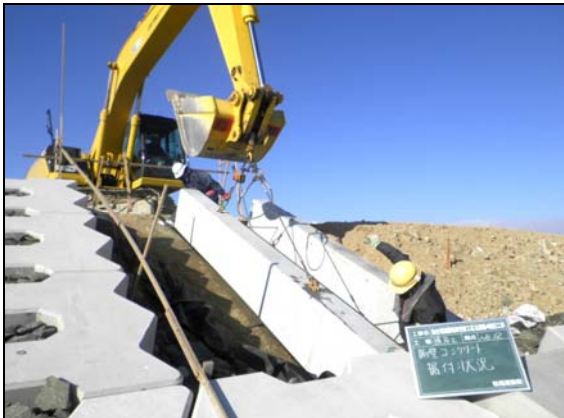
写真 4.1.2-219 付属物設置工 (隔壁工設置状況)
