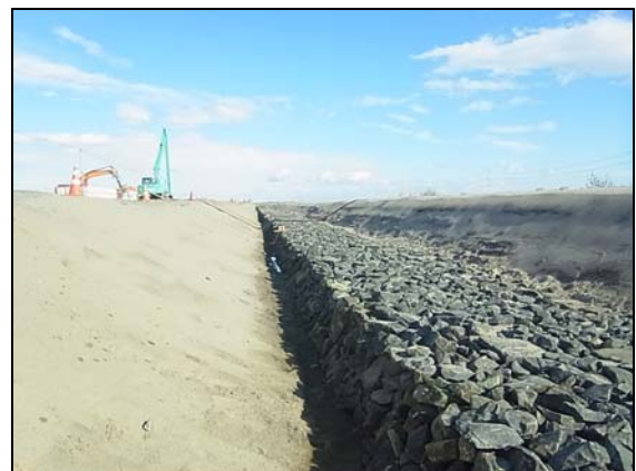
写真 4.1.2-79 護岸基礎工 (海側基礎工状況)
