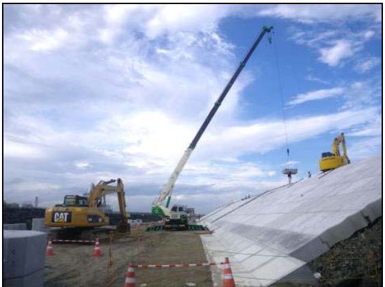
写真 4.1.2-211 護岸工 (天端被覆コンクリートブロック据付状況)
