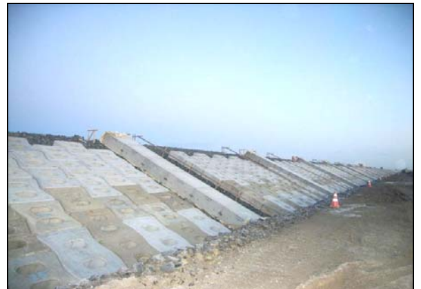
写真 4.1.2-106 付属物設置工 (隔壁工(海側)設置完了状況)
