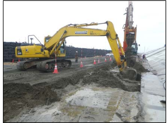
写真 4.1.2-157 地盤改良工 (陸側地盤改良工 2 層目状況)
