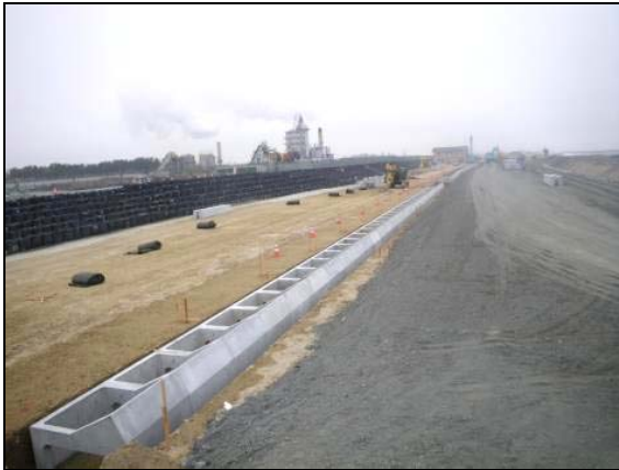
写真 4.1.2-192 護岸基礎工 (陸側護岸基礎工施工状況)
