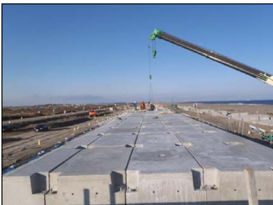
写真 4.1.2-93 護岸工 (天端被覆コンクリートブロック据付状況)
