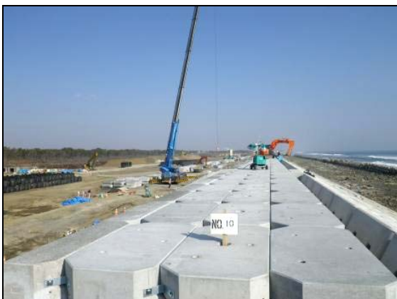
写真 4.1.2-174 護岸工 (天端被覆コンクリートブロック据付状況)
