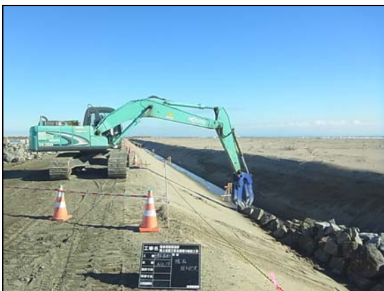
写真 4.1.2-76 護岸基礎工 (海側護岸基礎工施工状況)
