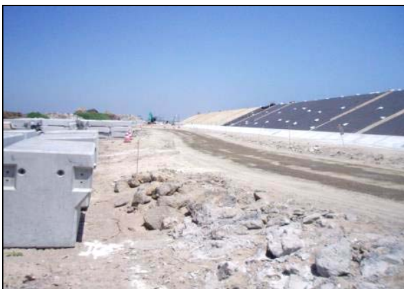
写真 4.1.2-242 護岸工 (裏法面被覆吸出し防止材敷設状況)
