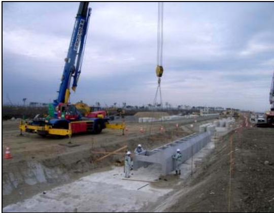
写真 4.1.2-42 護岸基礎工 (陸側護岸基礎工施工状況)
