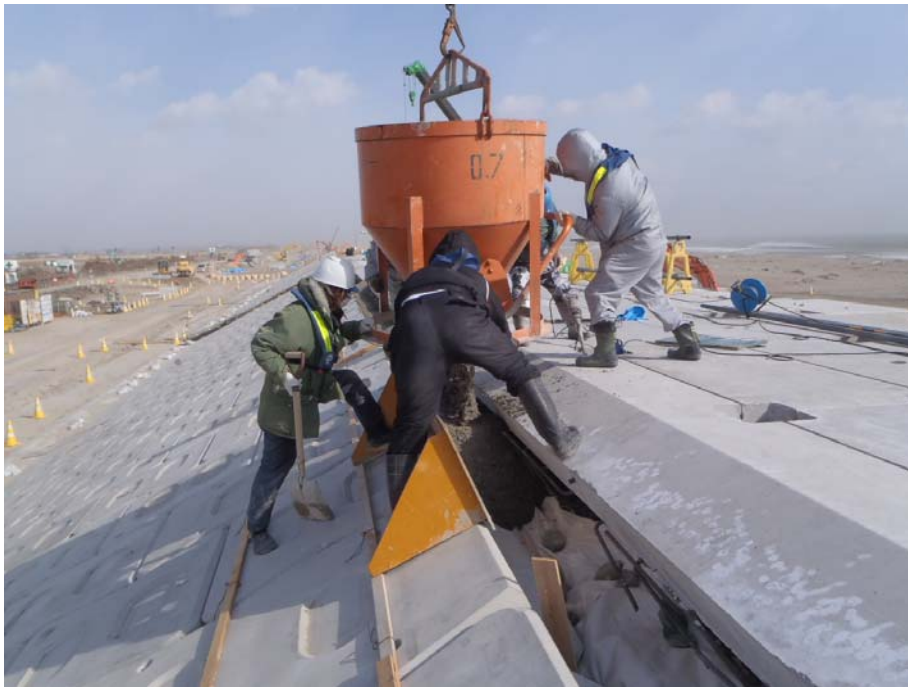
写真 4.1.6-17 陸側端部調整コンクリート施工状況
