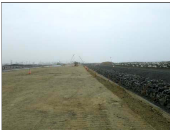
写真 4.1.2-236 護岸基礎工 (海側護岸基礎工状況)
