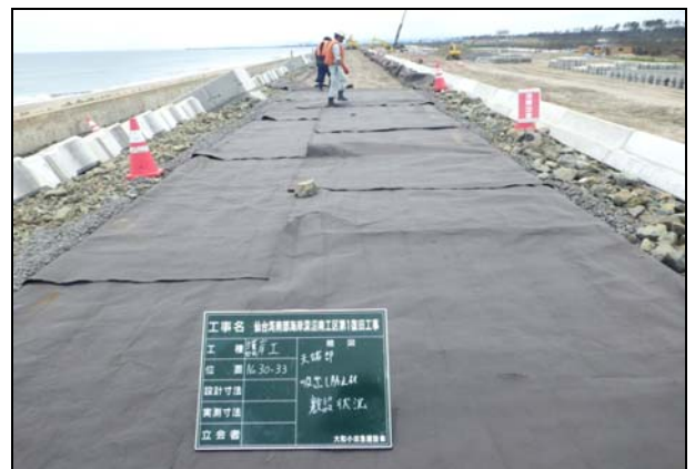
写真 4.1.2-52 護岸工 (天端被覆吸出し防止材状況)
