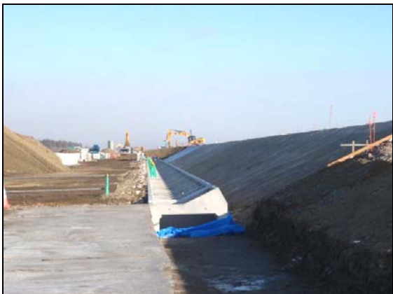
写真 4.1.2-119 護岸工 (裏法面被覆吸出し防止材敷設状況)
