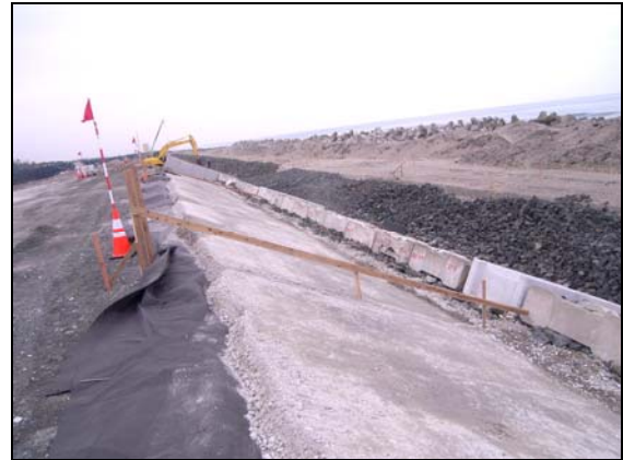
写真 4.1.2-170 護岸工 (表法被覆裏込碎石(RC-40)状況)
