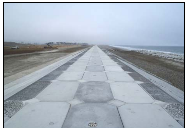
写真 4.1.2-134 護岸工 (天端被覆据付完了状況)
