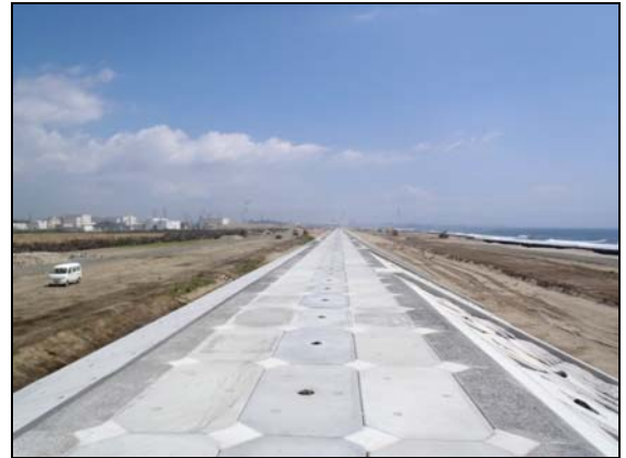
写真 4.1.2-31 護岸工 (天端被覆コンクリートブロック据付完了状況)
