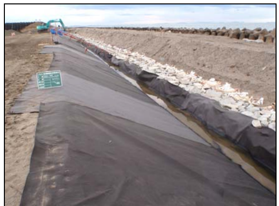
写真 4.1.2-165 護岸工 (表法面被覆吸出し防止材敷設状況)
