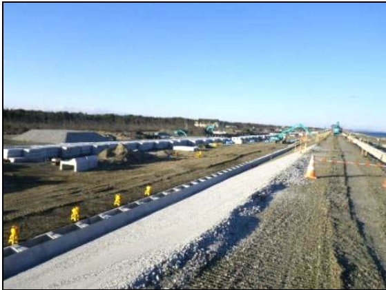
写真 4.1.2-167 護岸工 (裏法被覆裏込碎石(RC-40)状況)
