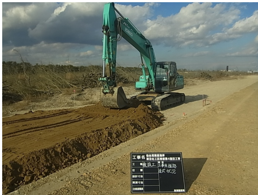
写真 4.1.9-1 工事用道路の築造状況
