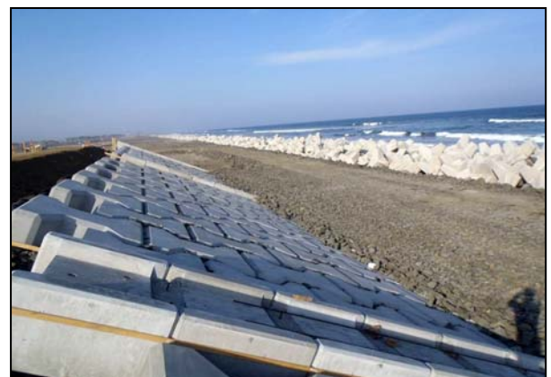
写真 4.1.2-149 消波ブロック工 (消波ブロック工据付完了状況)
