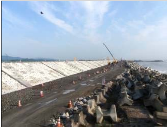
写真 4.1.2-259 表法尻保護工 (基礎割栗石敷設状況)
