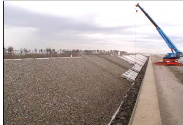
写真 4.1.2-133 護岸工 (表法被覆コンクリートブロック据付状況)
