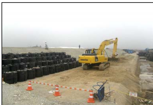
写真 4.1.2-187 仮設工（仮堤防設置状況）
