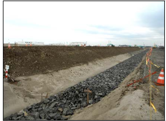
写真 4.1.2-14 護岸基礎工 (海側護岸基礎工完了状況)
