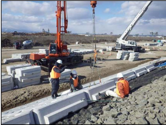
写真 4.1.2-58 護岸工 (裏法面被覆コンクリートブロック据付状況)
