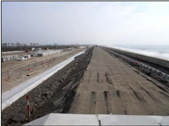
写真 4.1.2-48 海岸土工 (築堤盛土工完了状況)
