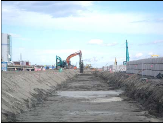
写真 4.1.2-74 地盤改良工 (陸側地盤改良工施工状況)
