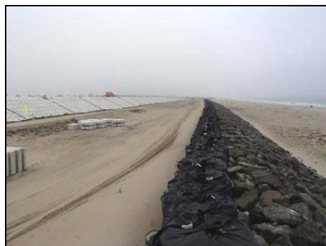
写真 4.1.2-3仮設工(工事用設道路工完了状況) 写真 4.1.2-4仮設工(仮堤防工設置完了状況)
