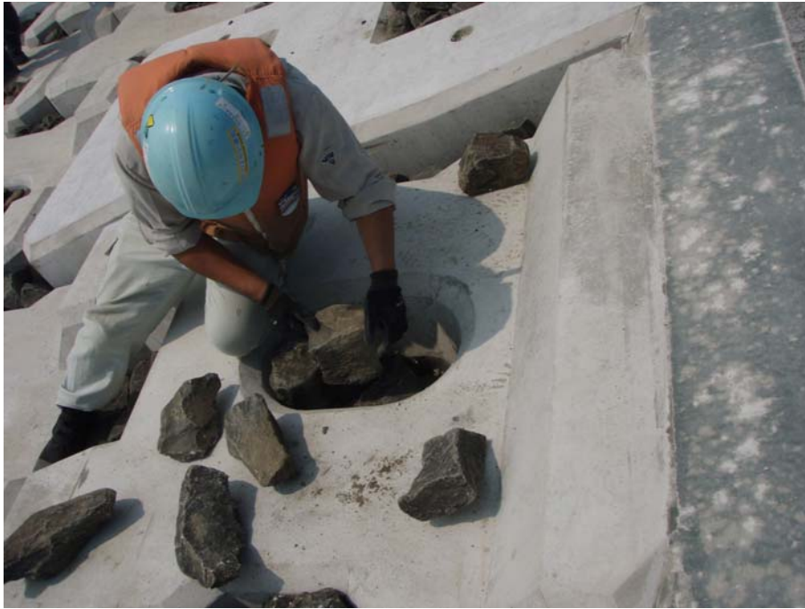
写真 4.1.6-20 間詰め施工例(粒径が大きい場合)
