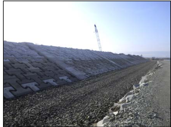
写真 4.1.2-261 表法尻保護工 (基礎割栗石敷設状況)
