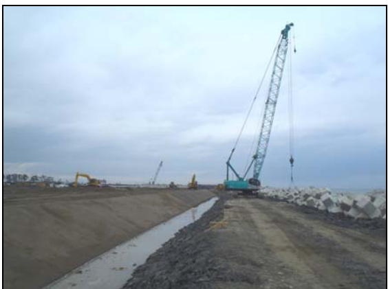
写真 4.1.2-146 消波ブロック工 (消波ブロック工据付状況)
