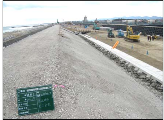
写真 4.1.2-206 護岸工 (天端被覆裏込砕石(RC-40)状況)
