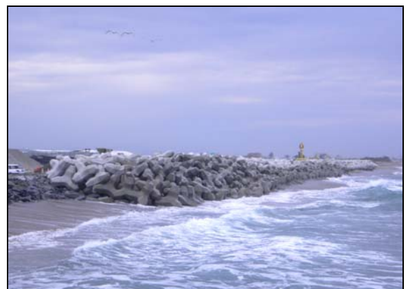
写真 4.1.2-229 消波ブロック工 (消波ブロック工据付完了状況)
