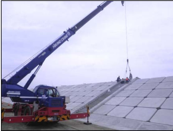
写真 4.1.2-262 付属物設置工 (階段工設置状況)
