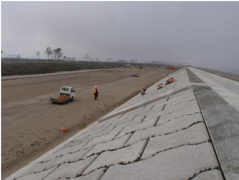
写真 4.1.6-8 割栗石充填例(5cm 以上開口部処理)
