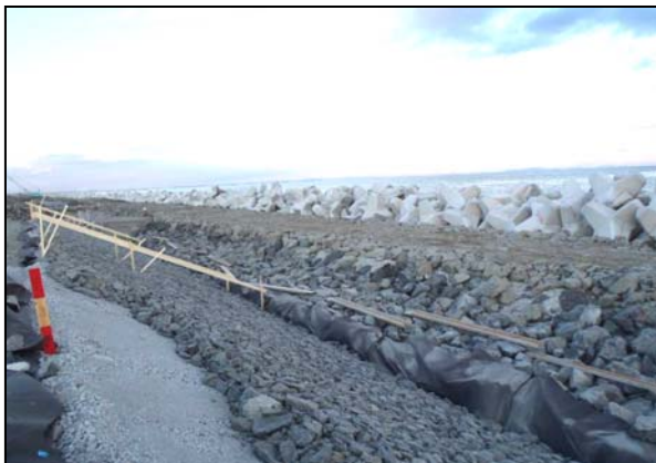
写真 4.1.2-125 護岸工 (法面被覆裏込碎石(割栗石)状況)
