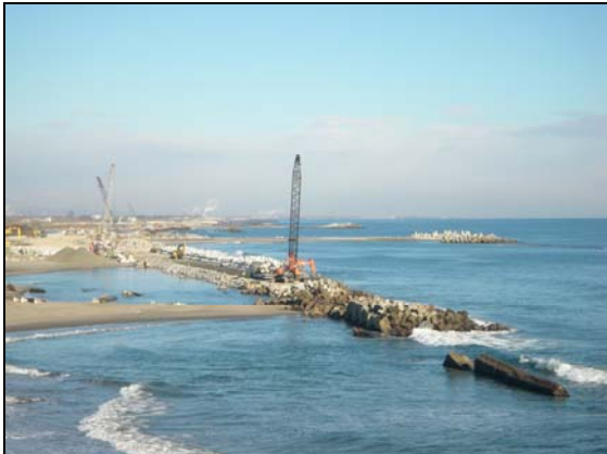
写真 4.1.2-267 消波ブロック工 (消波ブロック工据付状況)
