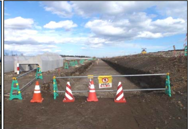
写真 4.1.2-114 地盤改良工 (陸側地盤改良工完了状況)
