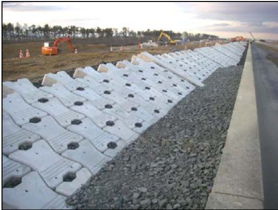
写真 4.1.2-136 表法尻保護工 (基礎割栗石敷設状況)
