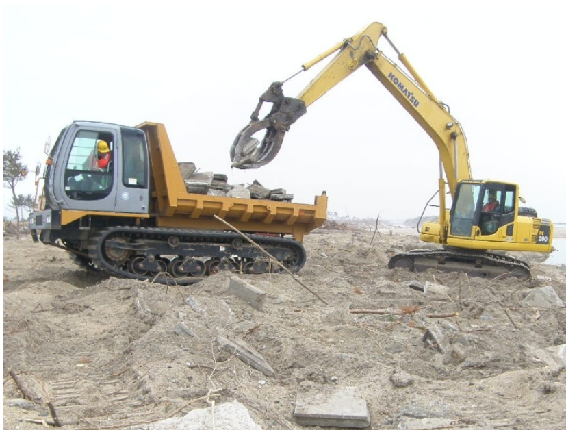
写真 4.1.9-3 不整地運搬車での運搬
