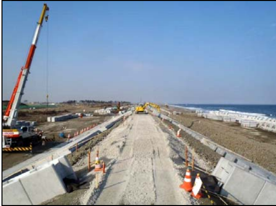
写真 4.1.2-123 護岸工 (天端被覆裏込碎石(RC-40)施工状況)
