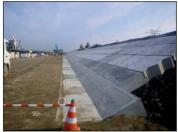
写真 4.1.2-195 護岸基礎工 (陸側護岸基礎工完了)
