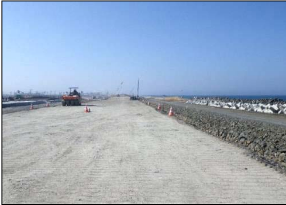
写真 4.1.2-240 海岸土工 (築堤盛土施工状況)
