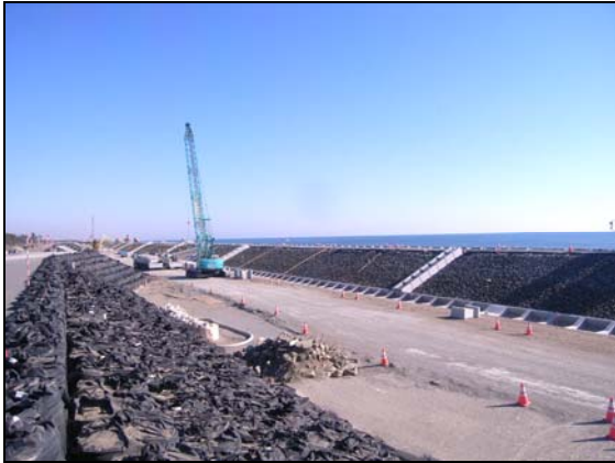
写真 4.1.2-172 護岸工 (裏法面被覆裏込砕石(割栗石)状況)
