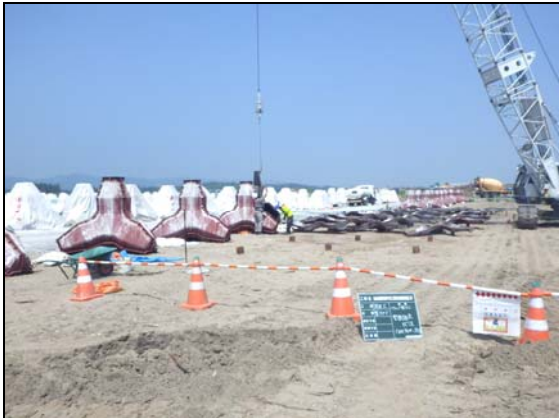
写真 4.1.2-266 消波ブロック工 (消波ブロック工製作状況)
