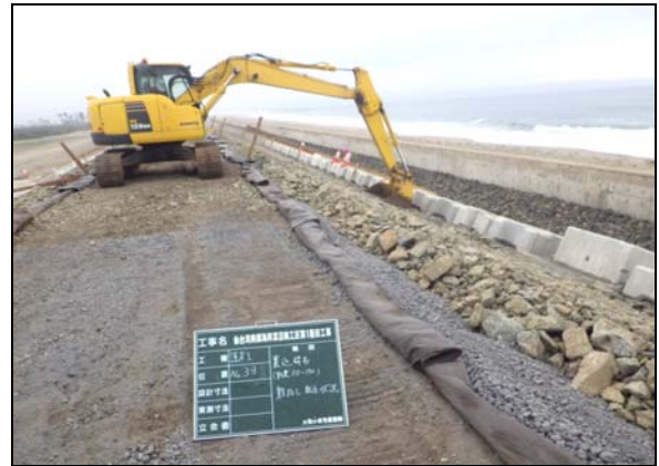
写真 4.1.2-56 護岸工 (法面被覆裏込砕石 (割栗石) 施工状況)
