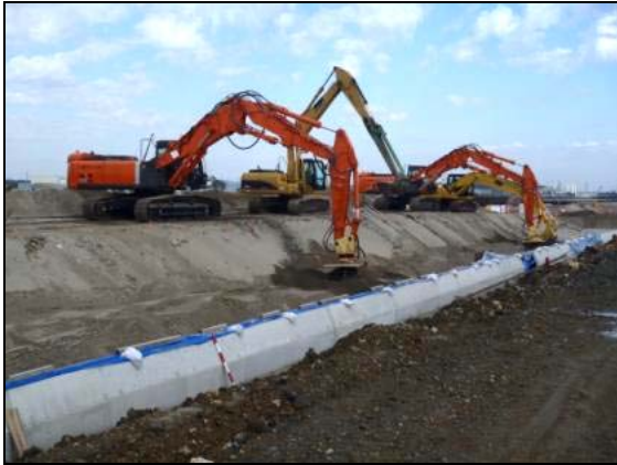
写真 4.1.2-5 地盤改良工 (陸側地盤改良 1 層目施工状況)
