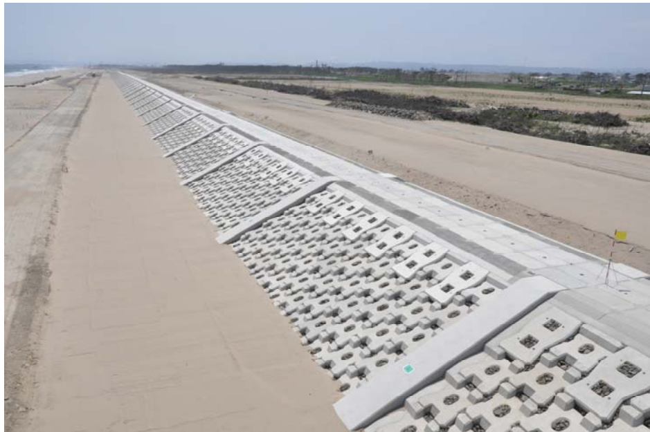
写真 4.1.3-7 砂による被覆例
