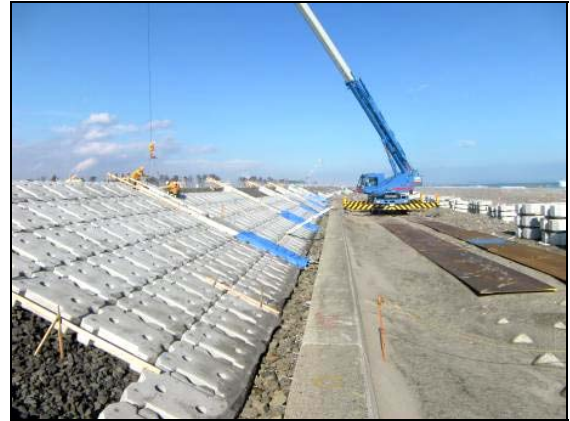
写真 4.1.2-61 護岸工 (表法面被覆コンクリートブロック据付状況)
