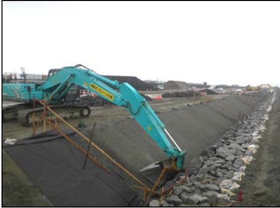
写真 4.1.2-203 護岸工 (被覆裏込砕石(RC-40)状況)
