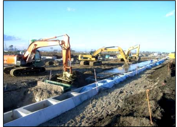
写真 4.1.2-44 地盤改良工 (陸側地盤改良工 2 層目施工状況)
