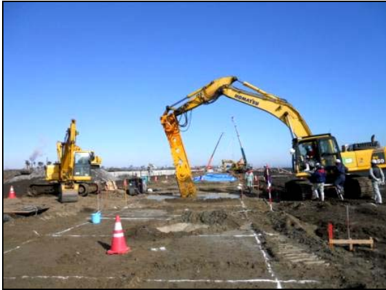
写真 4.1.2-41 地盤改良工 (陸側地盤改良工 1 層目施工状況)
