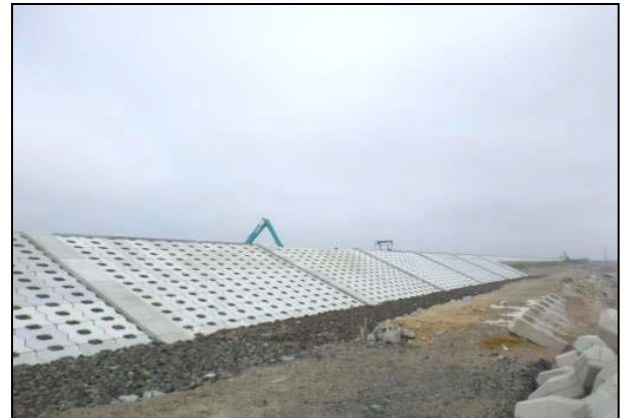
写真 4.1.2-222 付属物設置工 (隔壁工設置状況)
