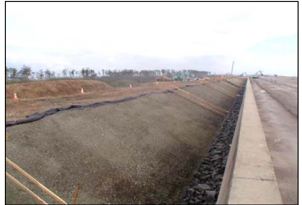
写真 4.1.2-127 護岸工 (表法被覆裏込碎石(RC-40)状況)
