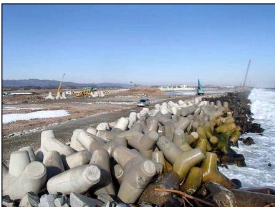
写真 4.1.2-268 消波ブロック工 (消波ブロック工据付完了状況)
