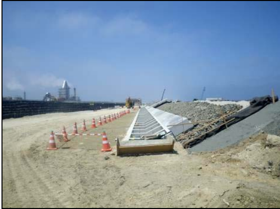
写真 4.1.2-209 護岸工 (裏法面被覆裏込砕石(割栗石)状況)
