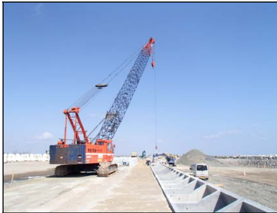
写真 4.1.2-235 護岸基礎工 (陸側護岸基礎工施工状況)
