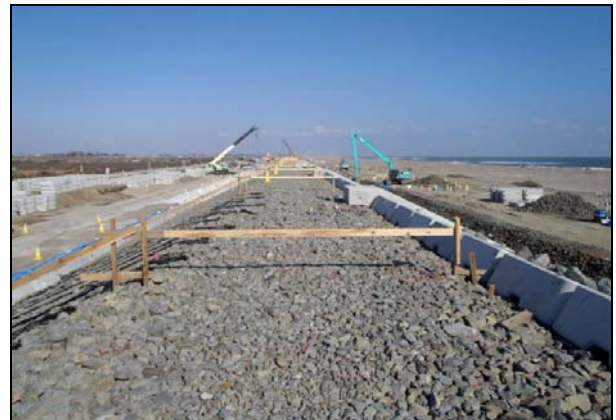
写真 4.1.2-90 護岸工 (天端被覆裏込砕石(割栗石)状況)
