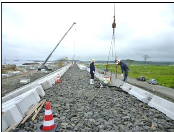
写真 4.1.2-254 護岸工 (天端被覆コンクリートブロック据付状況)
