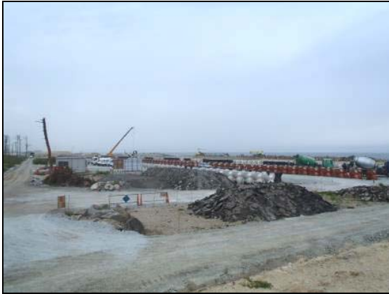
写真 4.1.2-224 消波ブロック工 (消波ブロック工製作状況)
