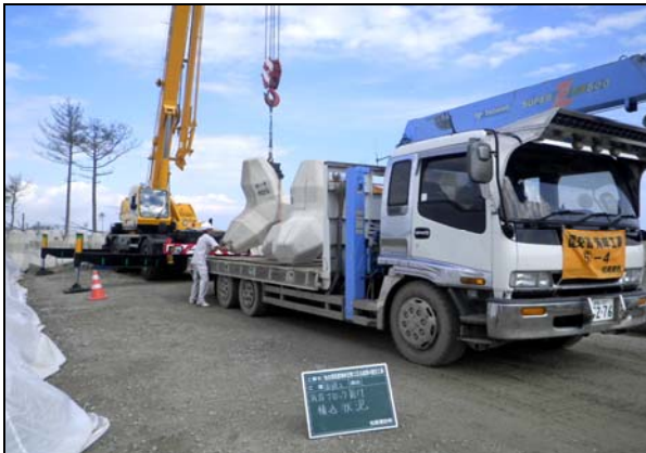
写真 4.1.2-225 消波ブロック工 (消波ブロック工積込・運搬状況)
