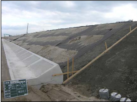
写真 4.1.2-17 護岸工 (裏法面被覆吸出し防止材状況)
