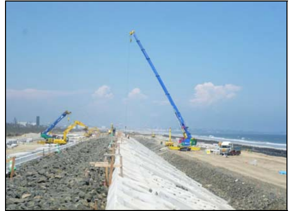
写真 4.1.2-30 護岸工 (表法面被覆コンクリートブロック据付状況)
