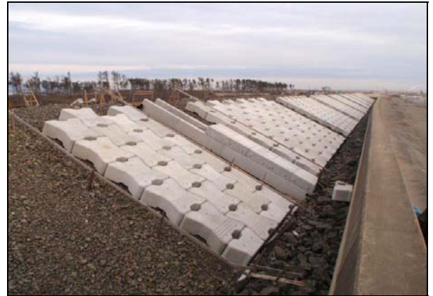
写真 4.1.2-142 付属物設置工 (隔壁工設置状況)
