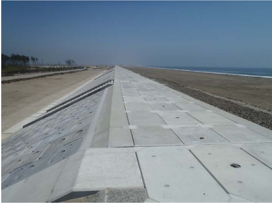
写真 4.1.7-1 後施工の例(ブラスト施工)
