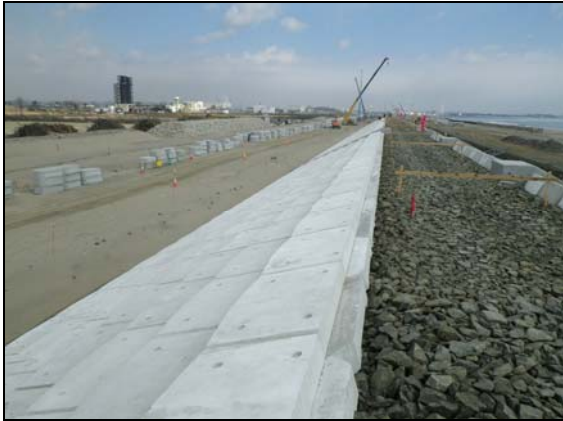
写真 4.1.2-27 護岸工 (裏法面被覆コンクリートブロック据付状況)
