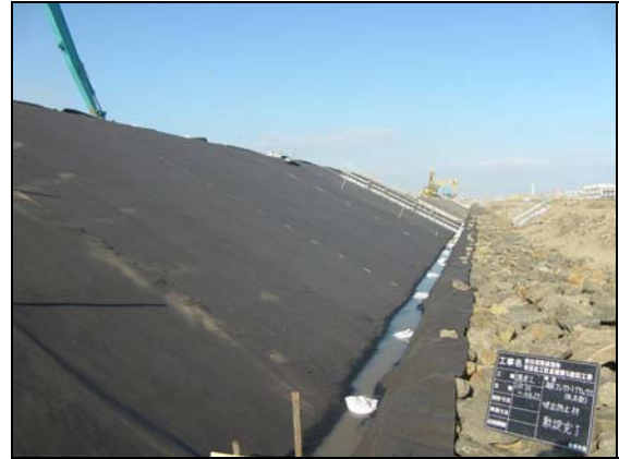
写真 4.1.2-20 護岸工 (表法面被覆吸出し防止材状況)
