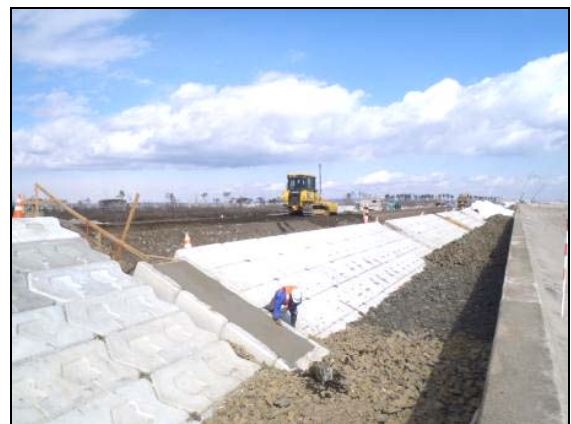
写真 4.1.2-68 付属物設置工 (隔壁工設置施工状況)
