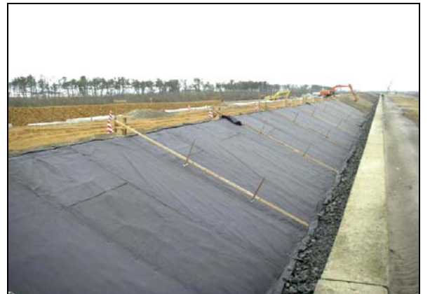
写真 4.1.2-122 護岸工 (表法面被覆吸出し防止材敷設状況)
