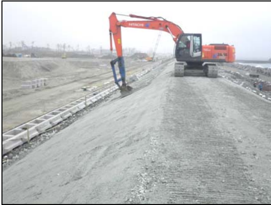
写真 4.1.2-246 護岸工 (被覆裏込砕石(RC-40)施工状況)
