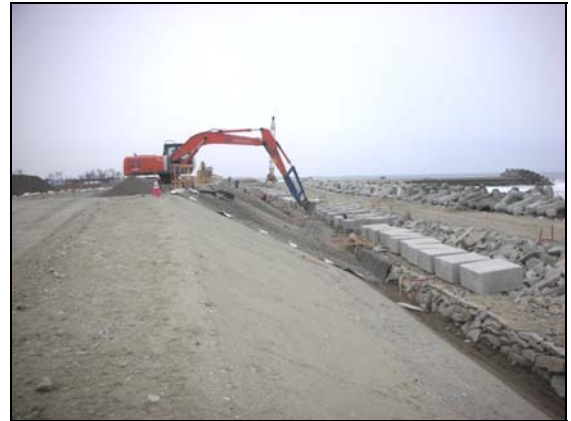
写真 4.1.2-250 護岸工 (表法被覆裏込砕石(RC-40)状況)
