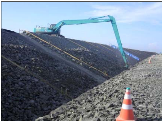
写真 4.1.2-87 護岸工 (法面・天端被覆裏込砕石(割栗石)施工状況)
