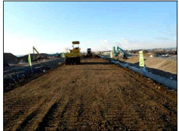
写真 4.1.2-15 海岸土工 (築堤盛土施工状況)
