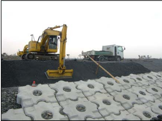
写真 4.1.2-53 護岸工 (法面被覆裏込砕石(RC-40)施工状況)
