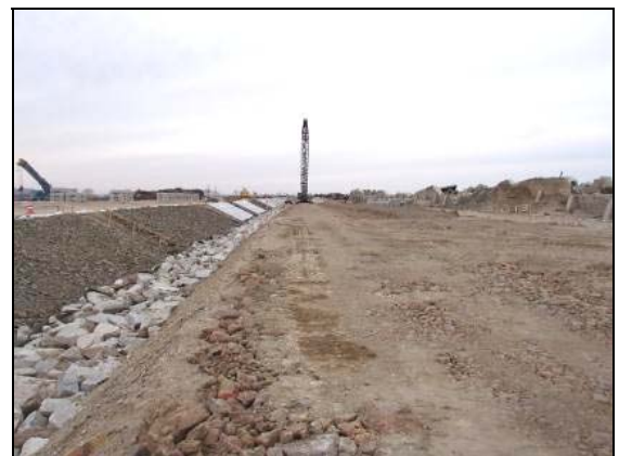
写真 4.1.2-239 護岸基礎工 (海側基礎工状況)
