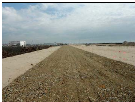
写真 4.1.2-3仮設工(工事用設道路工完了状況) 写真 4.1.2-4仮設工(仮堤防工設置完了状況)
