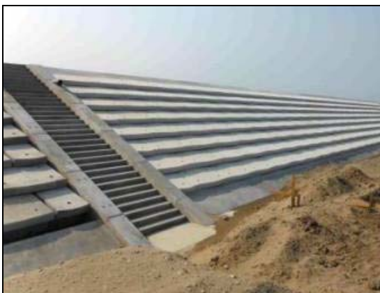
写真 4.1.2-35 付属物設置工 (階段工設置完了状況)
