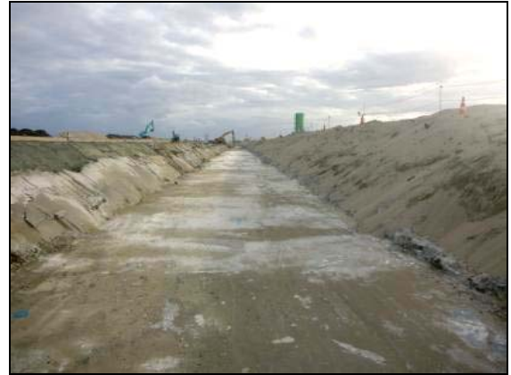
写真 4.1.2-8 地盤改良工 (陸側地盤改良工 1 層目完了状況)
