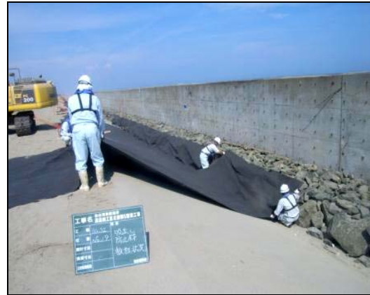
写真 4.1.2-51 護岸工 (法面被覆吸出し防止材施工状況)
