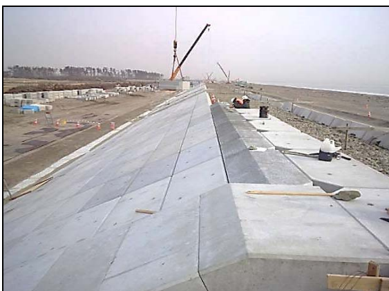
写真 4.1.2-131 護岸工 (天端被覆コンクリートブロック据付状況)
