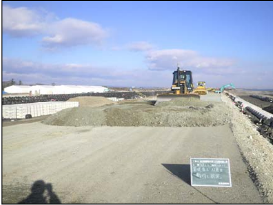
写真 4.1.2-197 海岸土工 (築堤盛土状況)
