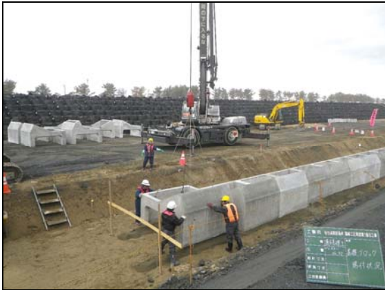
写真 4.1.2-155 護岸基礎 (陸側護岸基礎設置)
