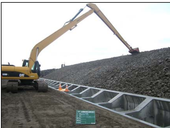
写真 4.1.2-168 護岸工 (法面被覆裏込碎石(割栗石)状況)
