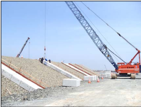
写真 4.1.2-263 付属物設置工 (隔壁工設置状況)
