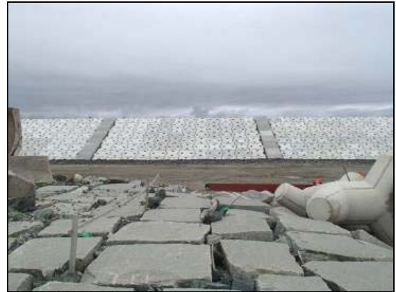
写真 4.1.2-265 付属物設置工 (隔壁工設置状況)
