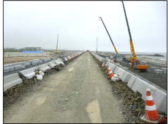
写真 4.1.2-249 護岸工 (天端被覆裏込砕石(RC-40)状況)
