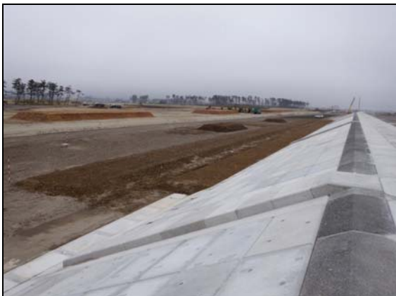
写真 4.1.2-103 付属物設置工 (隔壁工(陸側)設置完了状況)
