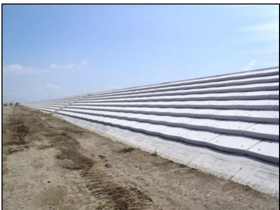
写真 4.1.2-29 護岸工 (裏法面被覆コンクリートブロック据付完了状況)
