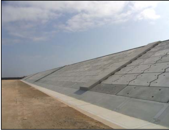
写真 4.1.2-215 護岸工 (裏法面被覆据付完了状況)
