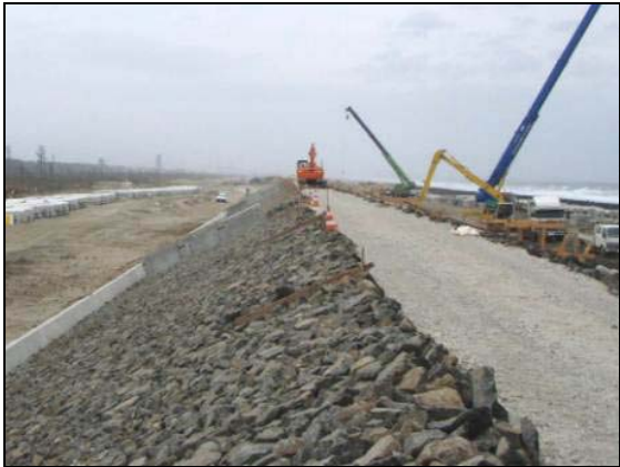
写真 4.1.2-24 護岸工 (裏法面被覆裏込碎石 (割栗石) 状況)
