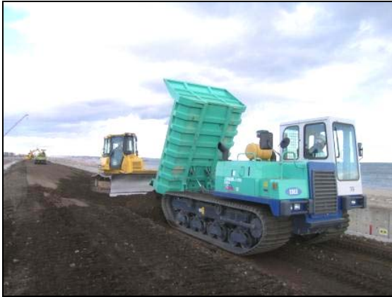
写真 4.1.2-47 海岸土工 (築堤盛土工状況)
