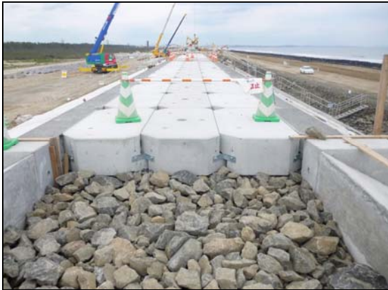
写真 4.1.2-28 護岸工 (天端被覆コンクリートブロック据付状況)
