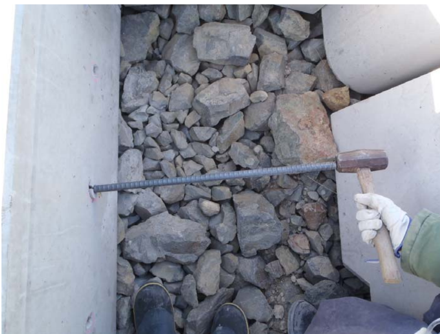
写真 4.1.7-5 法肩部現場打ち施工の例①
