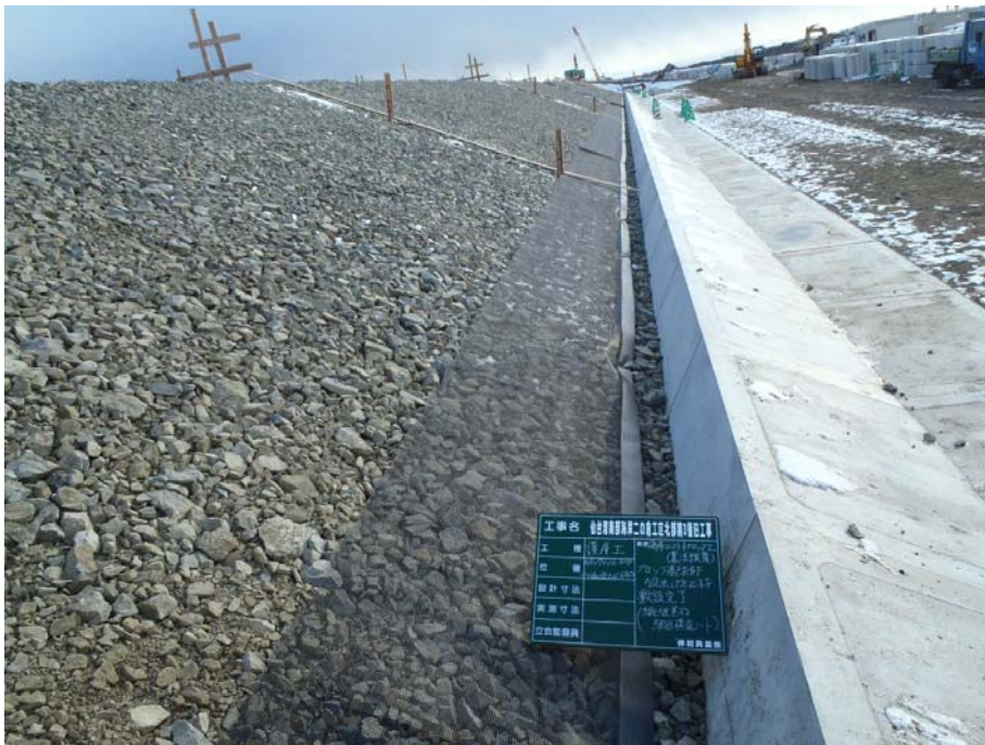
写真 4.1.6-6 吸出し防止ネット施工例(5cm 以上開口部処理)
