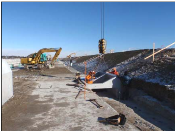
写真 4.1.2-112 護岸基礎工 (陸側護岸基礎工施工状況)
