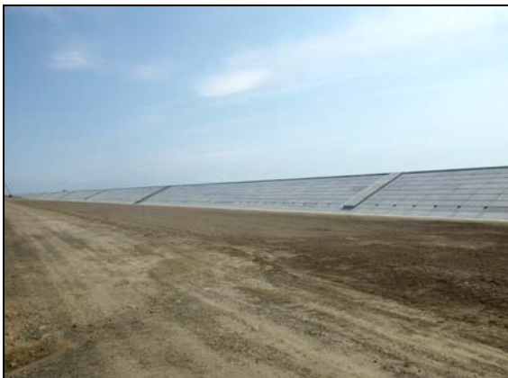
写真 4.1.2-140 付属物設置工 (隔壁工(陸側)設置完了状況)
