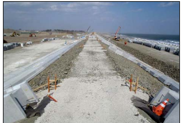
写真 4.1.2-128 護岸工 (天端被覆裏込碎石(割栗石)状況)
