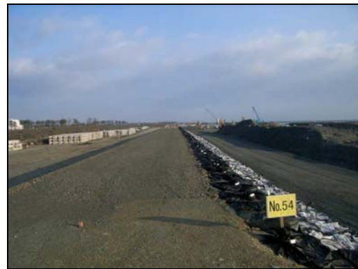
写真4.1.2-110 仮設工(仮堤防工設置完了状況)
