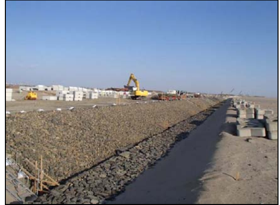
写真 4.1.2-94 護岸工 (表法面被覆裏込砕石(割栗石)状況)
