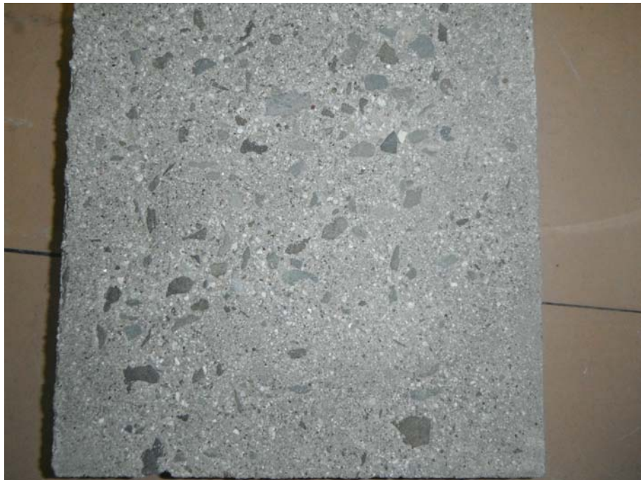
写真 4.1.7-2 後施工の例(ブラスト施工)
