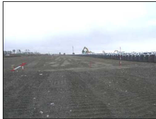
写真 4.1.2-108 仮設工(仮堤防基礎状況)
