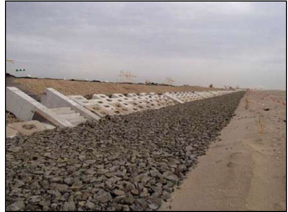
写真 4.1.2-99 護岸工 (表法面被覆据付完了状況)
