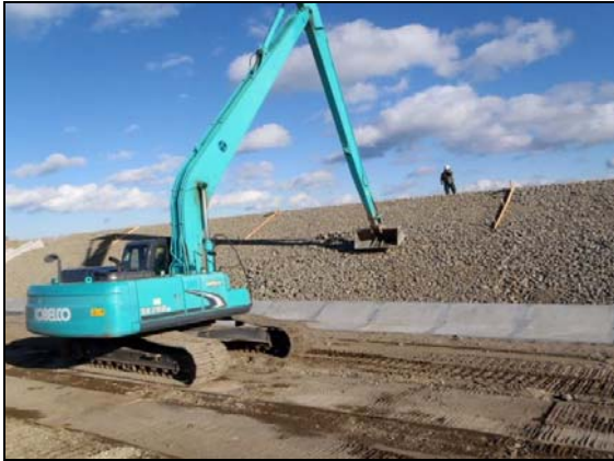
写真 4.1.2-85 護岸工 (裏法面被覆裏込砕石(RC-40)施工状況)
