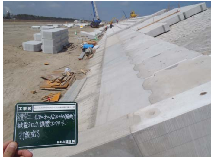
写真 4.1.6-15 陸側端部調整コンクリート設置例
