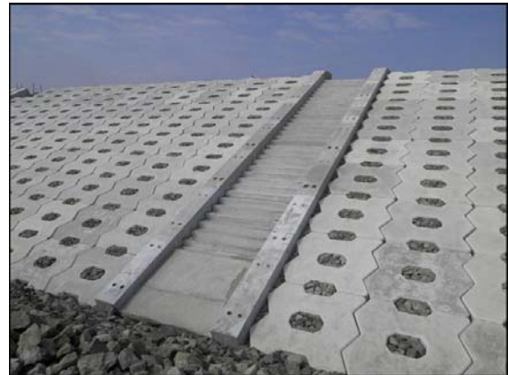
写真 4.1.2-221 付属物設置工 (階段工(海側)設置完了状況)
