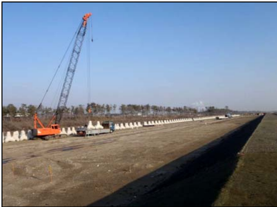
写真 4.1.2-145 消波ブロック工 (消波ブロック工運搬状況)
