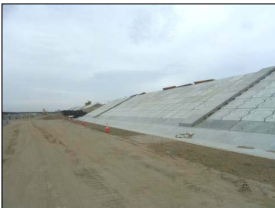
写真 4.1.2-220 付属物設置工 (隔壁工(陸側)設置完了状況)
