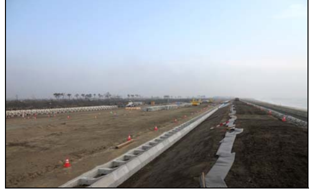
写真 4.1.2-45 護岸基礎工 (陸側護岸基礎工完了)
