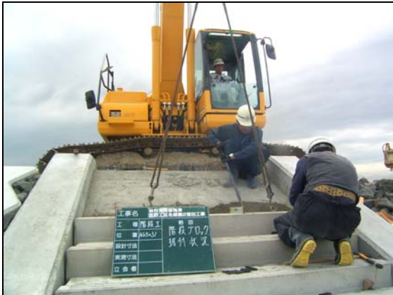
写真 4.1.2-218 付属物設置工 (階段工設置状況)
