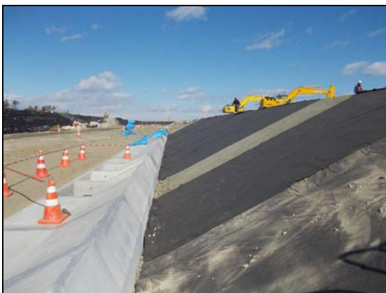
写真 4.1.2-162 護岸工 (裏法面被覆吸出し防止材敷設状況)
