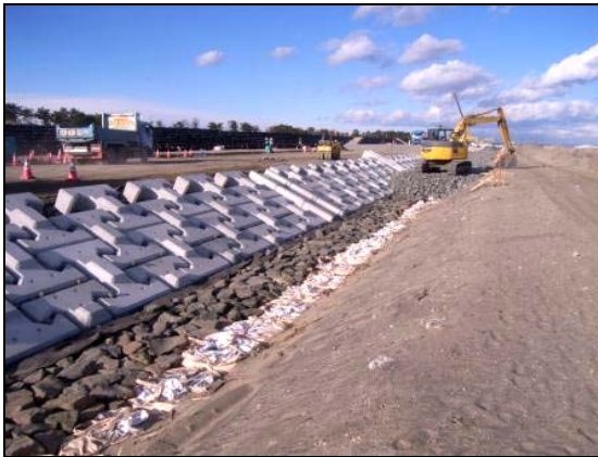
写真 4.1.2-179 表法尻保護工 (基礎割栗石敷設状況)
