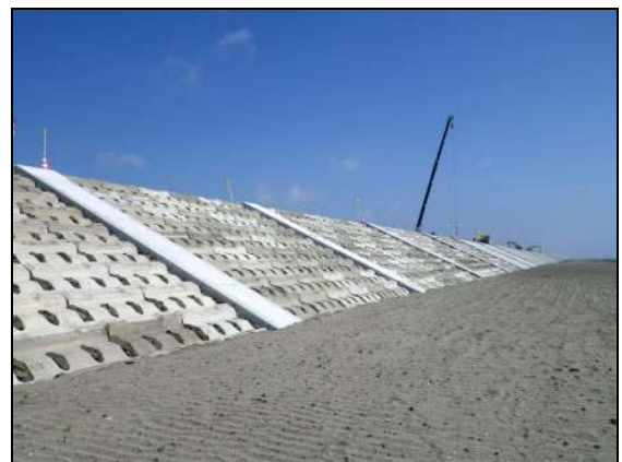
写真 4.1.2-186 付属物設置工 (隔壁工(海側)設置完了状況)
