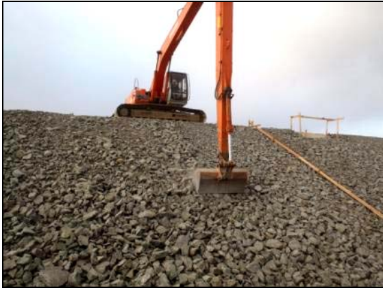
写真 4.1.2-23 護岸工 (法面被覆裏込碎石 (割栗石) 状況)
