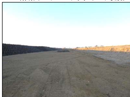
写真 4.1.2-190 構造物撤去工 （既設堤防撤去完了状況）
