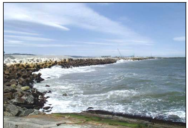
写真 4.1.2-271 消波ブロック工 (消波ブロック工据付完了状況)
