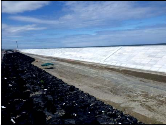
写真 4.1.2-178 護岸工 (裏法面被覆据付完了状況)
