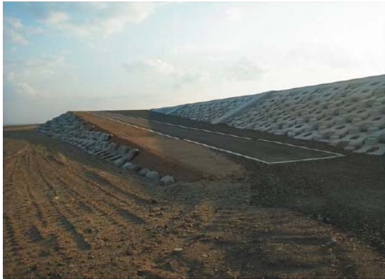
写真 3.2.6-1 深沼北工区(海側)
