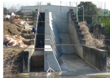
写真-2 高落差実験水路（縮尺1/2）
