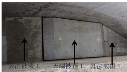
写真-9 法肩ブロックを天端被覆工と一体化したケース（高落差実験水路）
