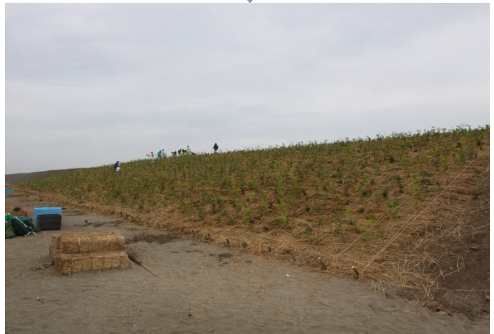
植樹後（堤防の下から）
