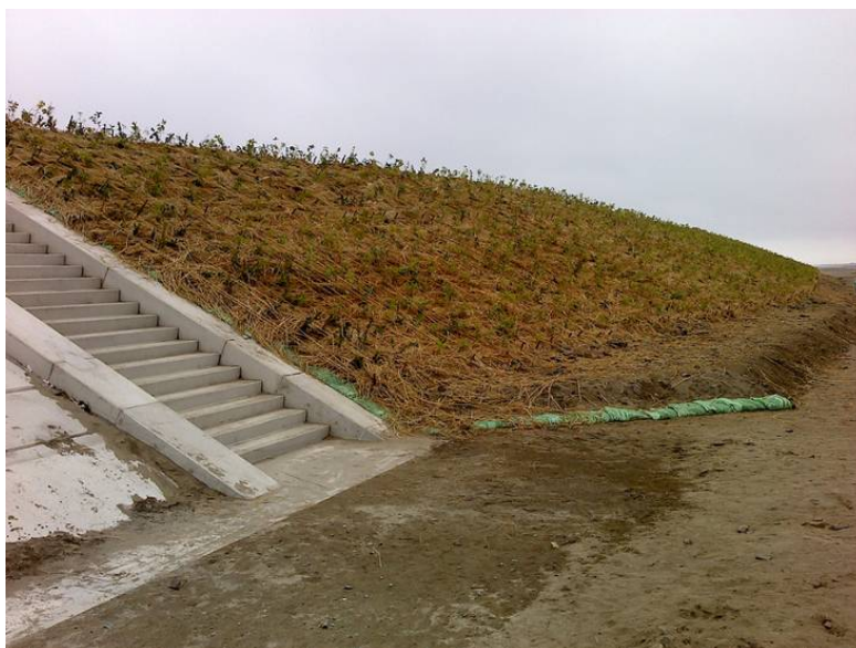
植樹完了状況（堤防の下から）
