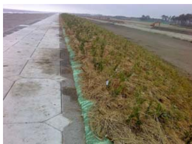
植樹完了状況（堤防の上から）
