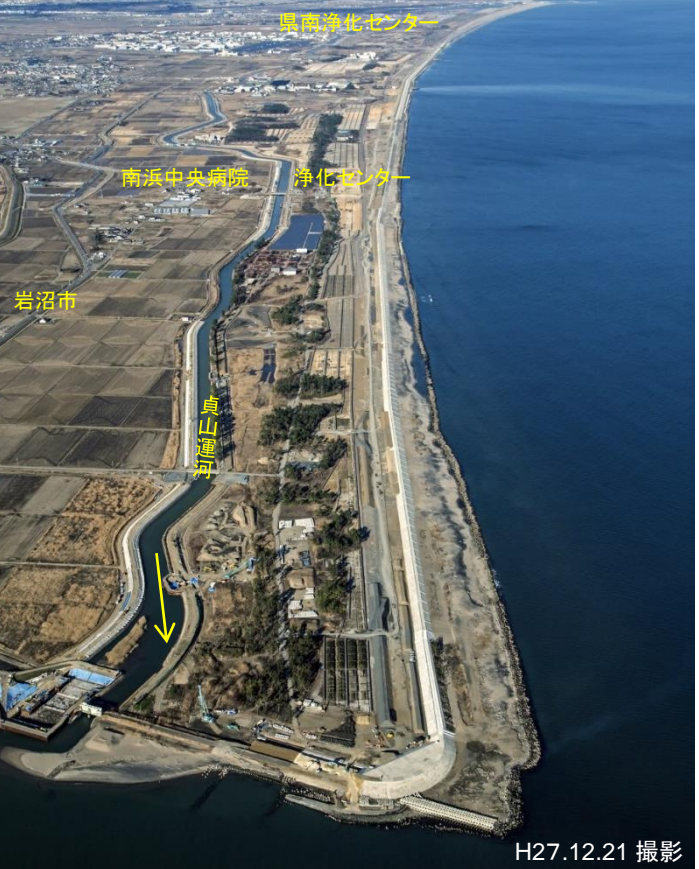
▲震災後本復旧後
