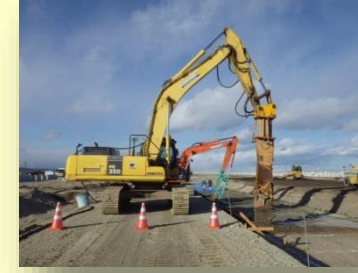
【①陸側基礎地盤改良】
