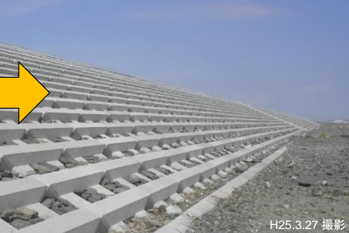
▲震災後本復旧後の堤防 (蒲崎)
