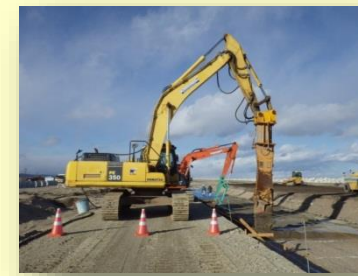
【①陸側基礎地盤改良】
