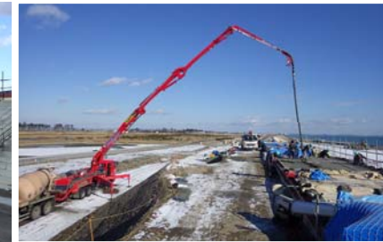
▲仙台湾海岸深沼地区海岸深沼南工区(CSG堤防最終Co打設状況)
