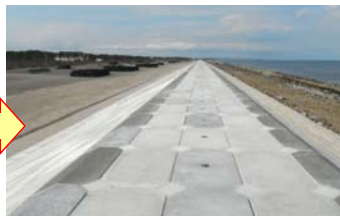
復旧完了状況(平成25年3月)
