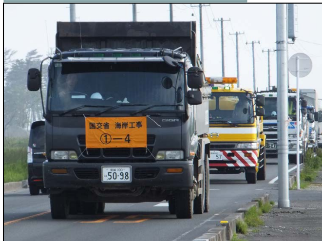
土砂運搬車両 運行状況
