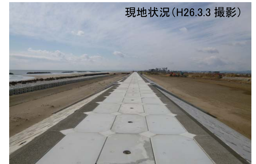
④海水浴場北側の堤防天端からの南方向
