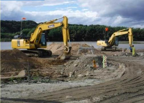
令和元年10月の東日本台風（台風第19号）により被災した阿武隈川下流の治水対策として坂津田地区において河道掘削を実施している。
