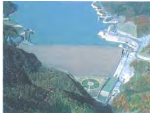
七ヶ宿ダム[H3 完成]
