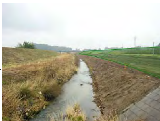
内川支川五福谷川右岸の無堤部(上流より)
