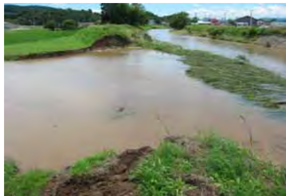
平成14年7月台風6号の出水により破堤した荒川（左岸）
