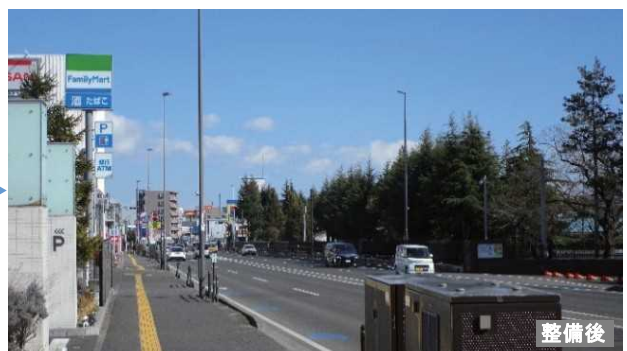
倒壊等により交通の妨げとなる電線や電柱を撤去し、被災時でも交通の確保が可能となるよう電線共同溝を整備（国道45号 仙台市宮城野区）
