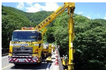
橋梁点検： 橋の下のひび割れ等を点検
