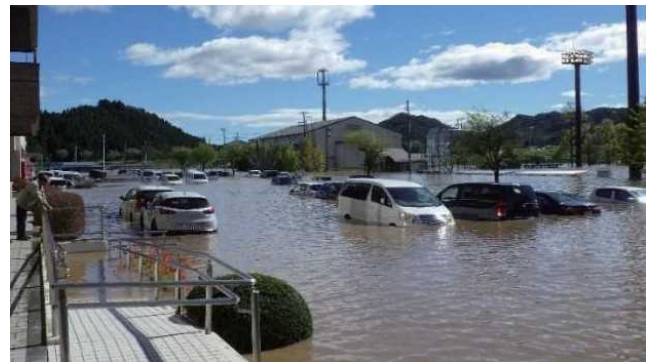
浸水被害を受けた丸森町役場の駐車場
