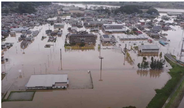
令和元年東日本台風により浸水被害をうけた丸森町役場周辺地域
