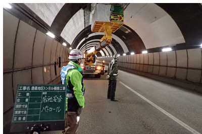
トンネル定期点検： 天井のひび割れ箇所等の点検
