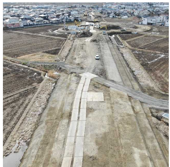
▲ ① 改良が進む境野宮地区 (R6.2撮影)
