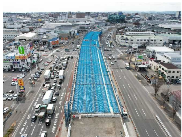
▲ 上部工【仮称】箱堤高架橋の施工状況 (R6.2撮影)
