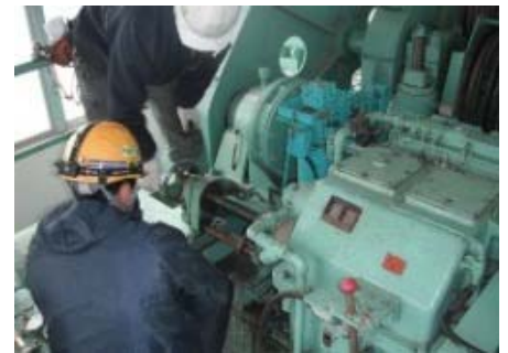
機械設備の点検整備 (月1回、詳細点検年1回)
