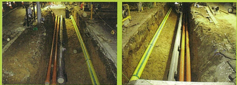
歩道を掘って電気や通信の管をまとめて地中に埋めます。
