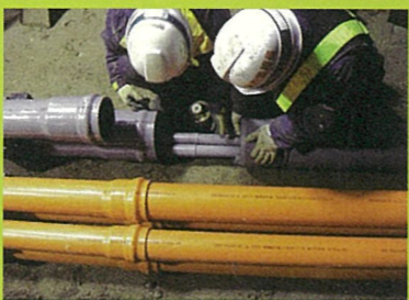
電線が入る管をつないでいます。
