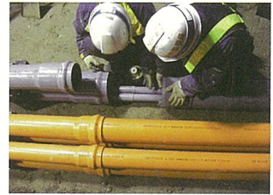
管路接続状況
