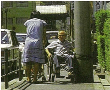
電柱が車いす等の通行の妨げとなっている歩道
