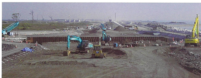
▲堤防復旧工事の様子（山元海岸）
