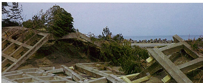
▲海岸堤防の被災状況（岩沼海岸）
