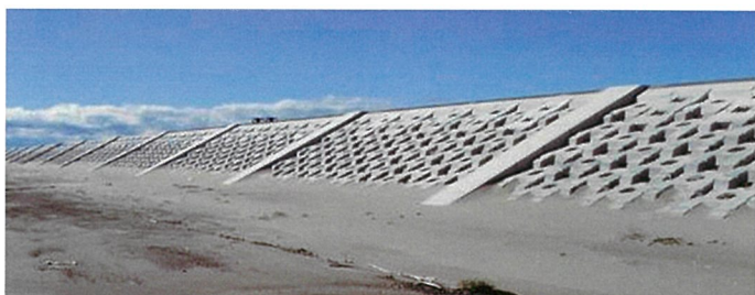
▲完成した海岸堤防
