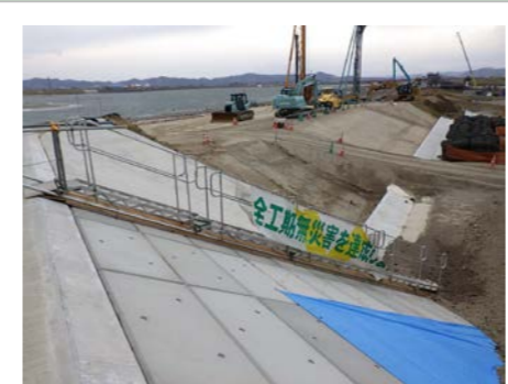
阿武隈川下流寺島2工区 災害復旧工事(施工中)
