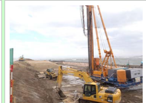
阿武隈川下流寺島3工区 災害復旧工事(施工中)
