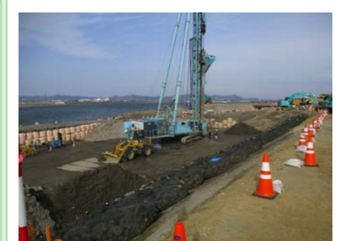
阿武隈川下流寺島川向下流工区災害復旧工事(施工中)
