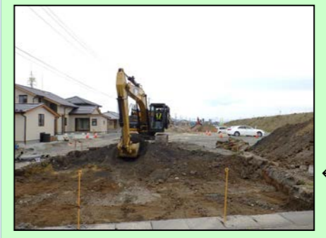
← 堤防を作るために必要な土地にある県道を付け替え中
