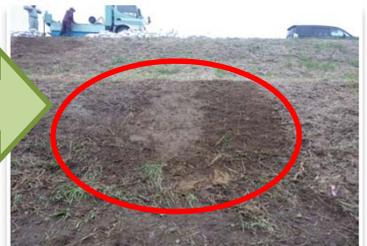
岩沼出張所では、このような堤防の損傷により、洪水時に堤防の決壊などに至らないよう早急な埋め戻しを行い、自治体や行政機関と連携し継続的な河川巡視に努めて参ります。
