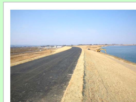
阿武隈川下流荒浜9工区堤防災害復旧工事(完成)
