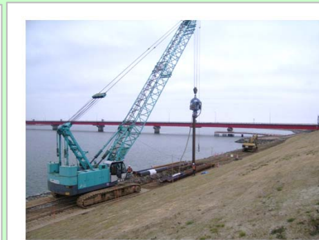
阿武隈川下流荒浜堤防護岸災害復旧工事(施工中)
