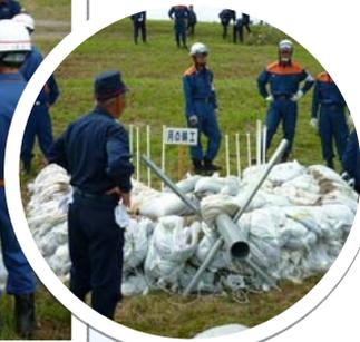
川の水が堤防基盤を通って堤防の裏側に漏れ出しているような箇所に、土のうを半円状に積み上げてプールを作ります。こうすることによって、川の水位と漏れ出した箇所の水位を近づけて水の圧力を弱め、漏水の拡大を防ぐ工法です。
