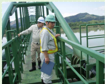
阿武隈川水管橋
