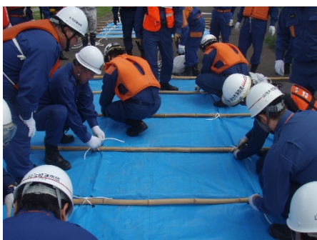
シート張り工法
