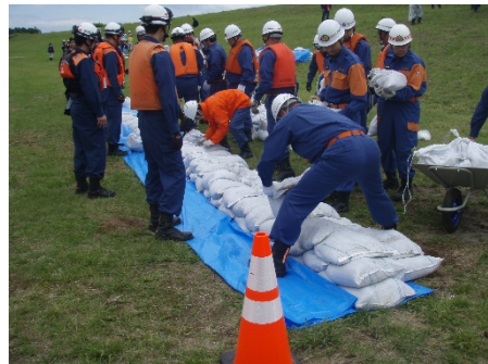
改良積土のう工法
