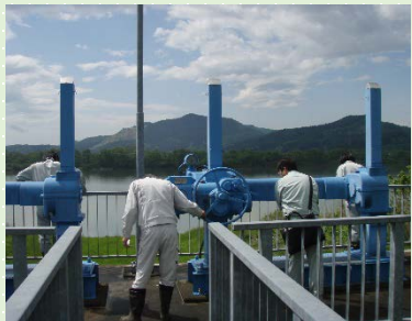
四日市場排水機場
