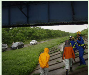
阿武隈川鉄道橋
