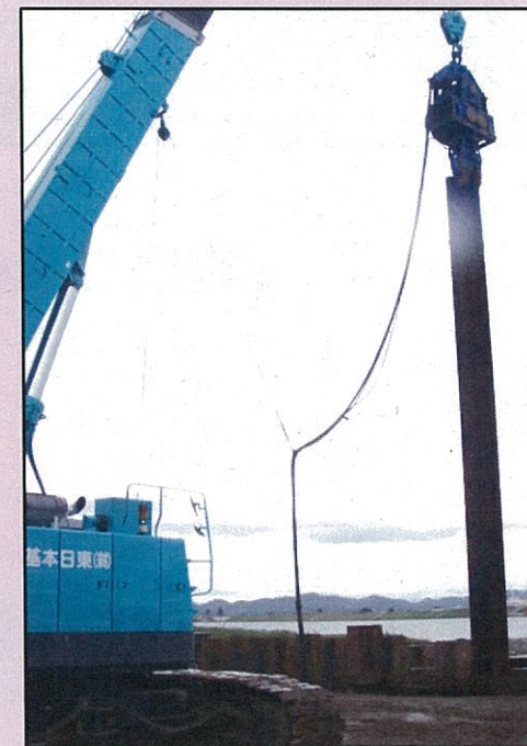
【矢板打設状況】
