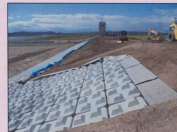
【施工中 築堤盛土・ブロック設置】 H29.9月現在
