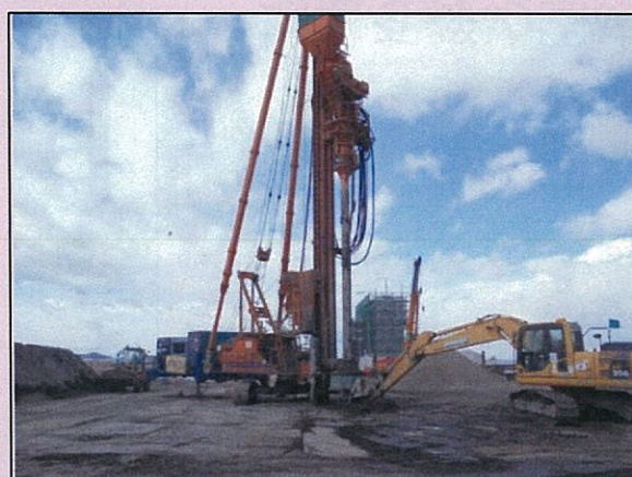
【施工中 地盤改良工】 H29.4月現在
