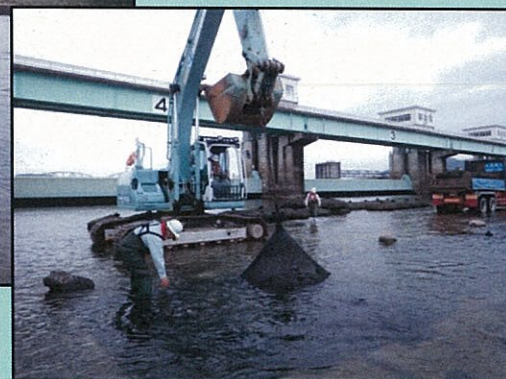
【袋詰め根固め(2t型)ブロック設置】
