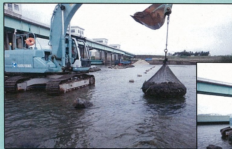
【袋詰め根固め(2t型)ブロック設置】
