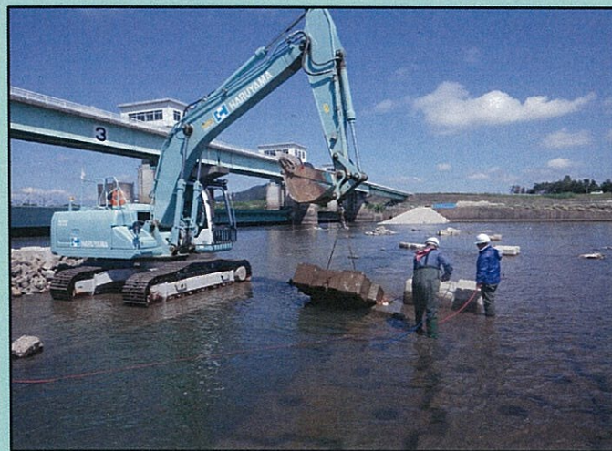
【既設護床エブロックの撤去】
