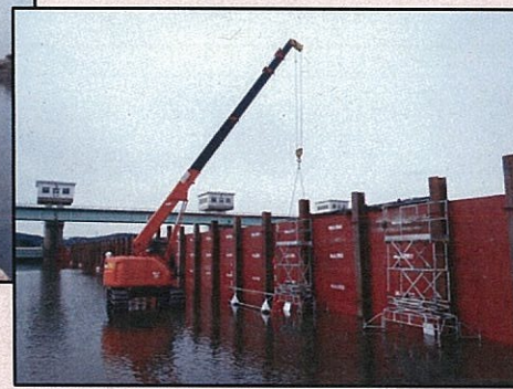
【②仮締切工(矢板打込)】
