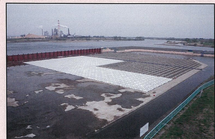
【施工後】（護床ブロック復旧後）
