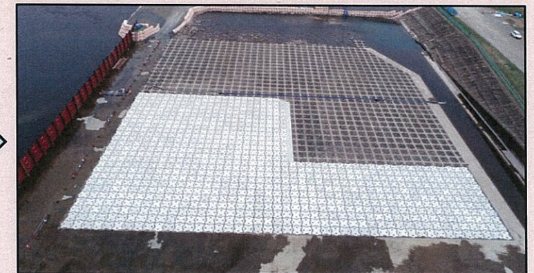
【護床ブロック設置 完成】
