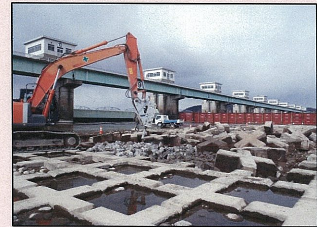
【③既設コンクリート取壊し】
