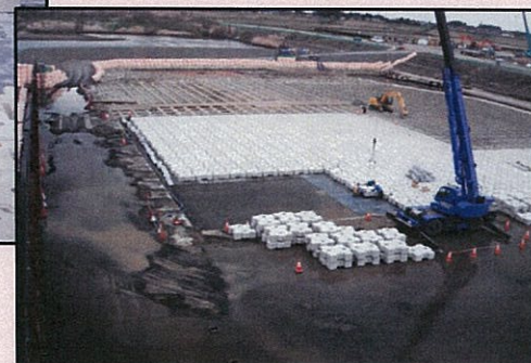
【⑤護床ブロック据付】
