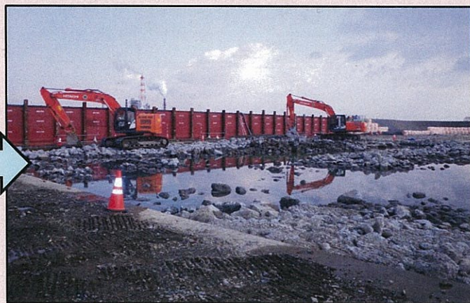
【④盛土工(捨石)】
