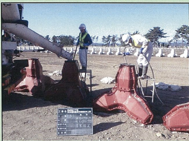
【①コンクリート打設】
