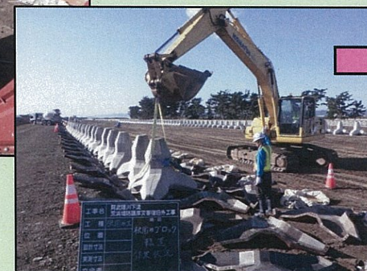
【③型枠を外す】
