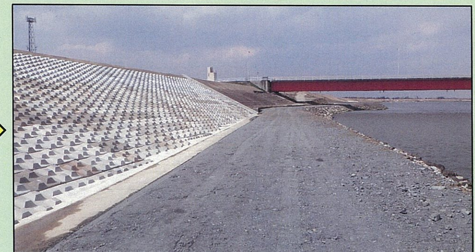
【施工中 平成29年5月時点】
