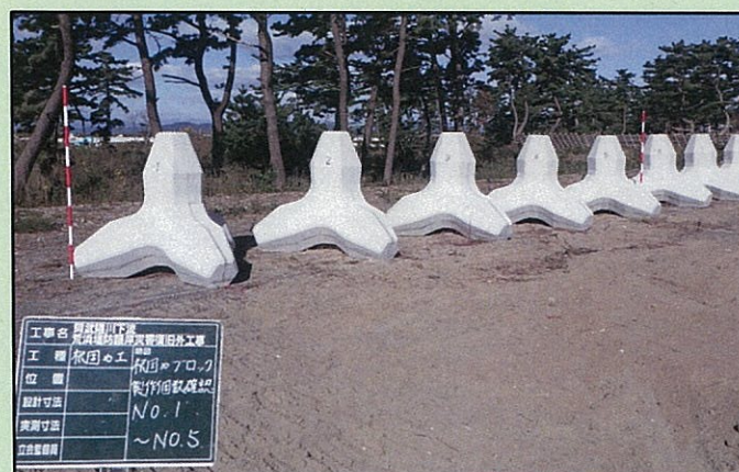
【根固めブロック完成】
