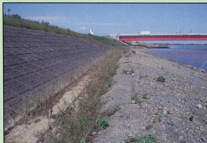
【施工前 平成28年10月時点】
