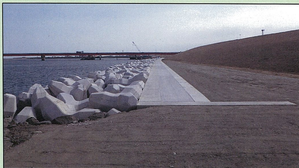
【根固めブロック投入完成イメージ】
