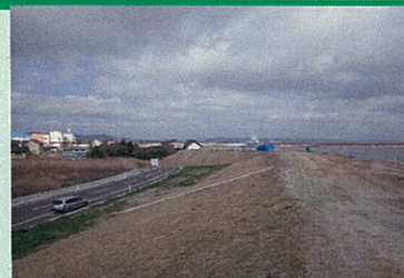
【災害復旧工事：堤防復旧】 巨理町 荒浜地区 H29.4現在
