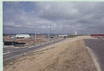
【災害復旧工事：堤防復旧】 巨理町 山神地区 H29.4現在
