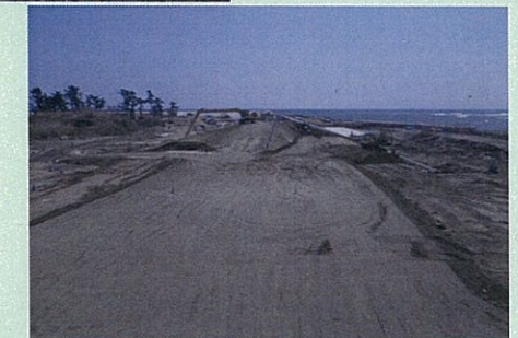
【災害復旧工事：堤防復旧】 岩沼市 寺島地区 H29.4月現在
