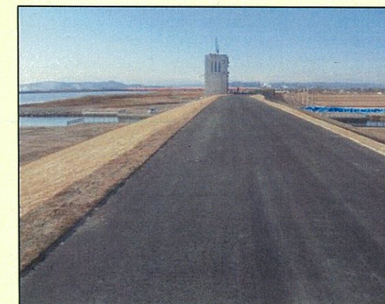
【天端舗装完了】
