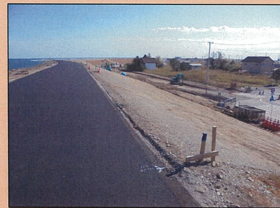
【完成 張芝・天端舗装】 平成29年11月現在
