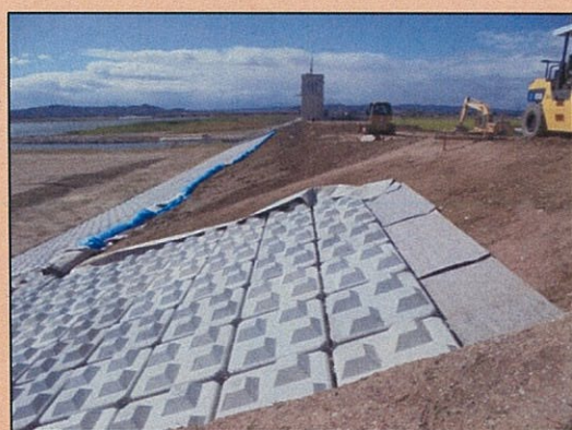
【施工状況 築堤盛土・ブロック設置】 平成29年9月現在
