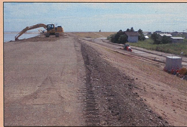
【施工状況 築堤盛土】 平成29年9月現在
