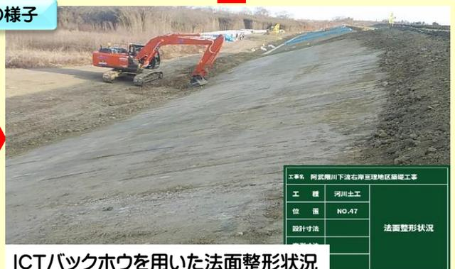
ICTバックホウを用いた法面整形状況
