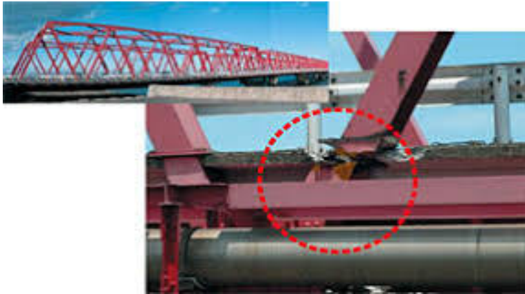
舗装損傷の例
