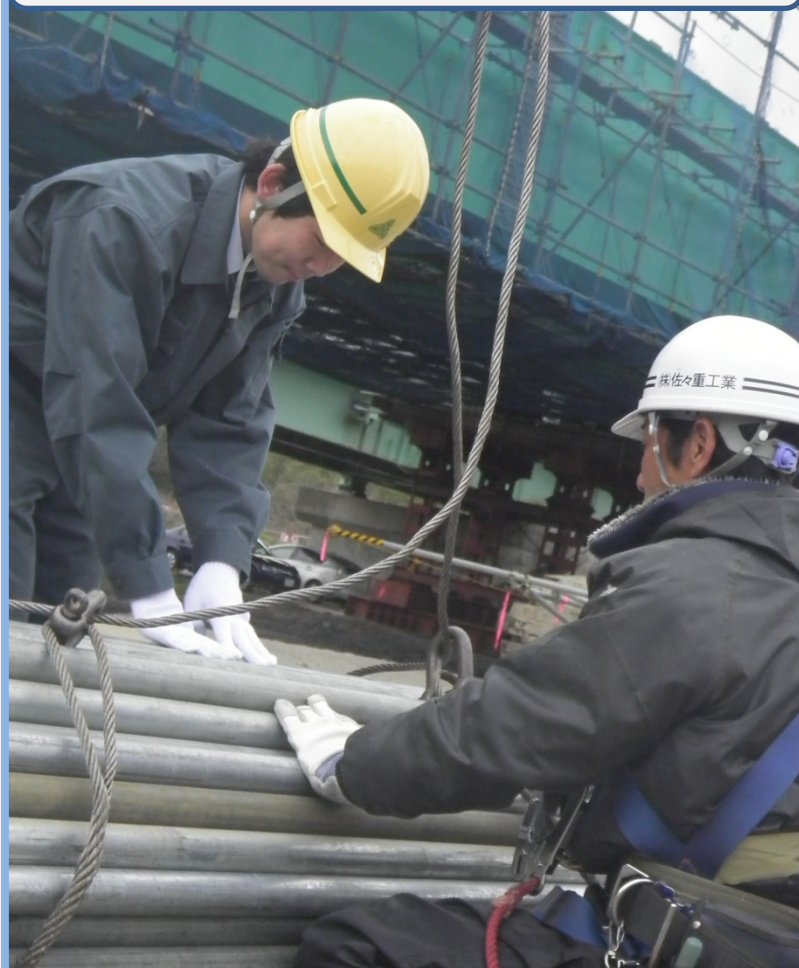
吊り荷にワイヤーロープを掛ける様子
