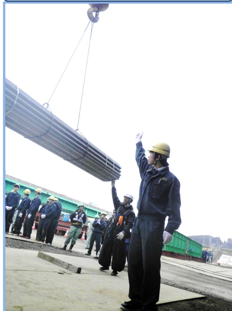
クレーンオペレータに合図をする様子
