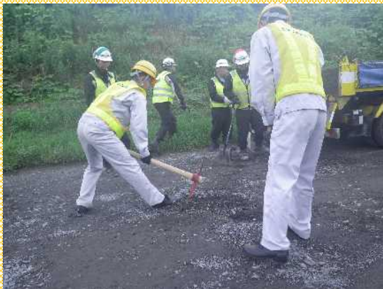
6/28 側道補修の様子
