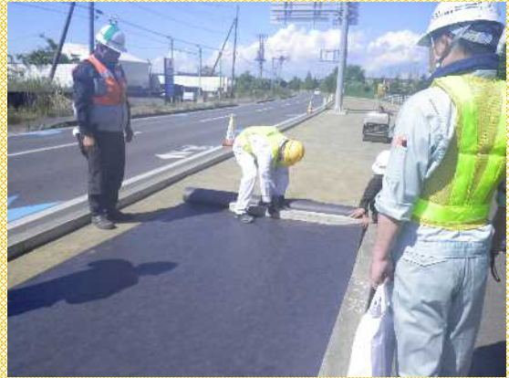
8/30 防草シート設置の様子
