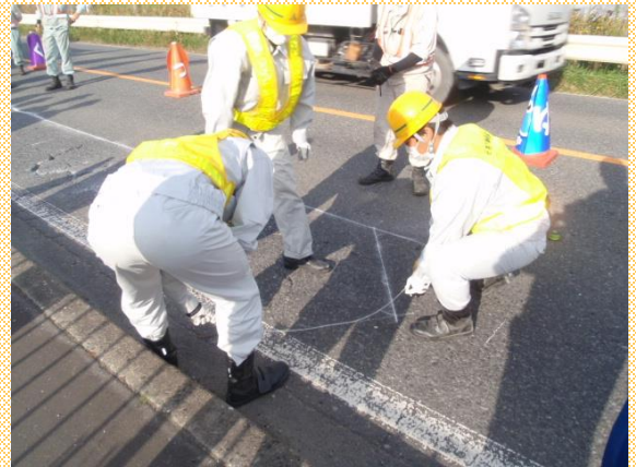
10/28 舗装補修(パッチング)の様子
