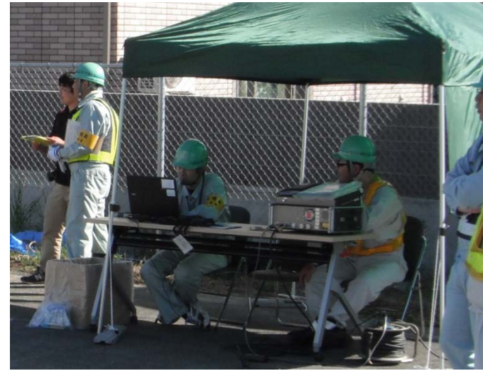
▼機器による検測状況
