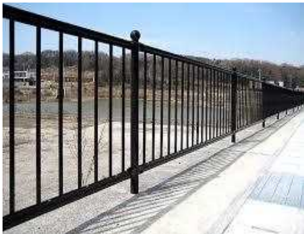
●転落防止柵更新
