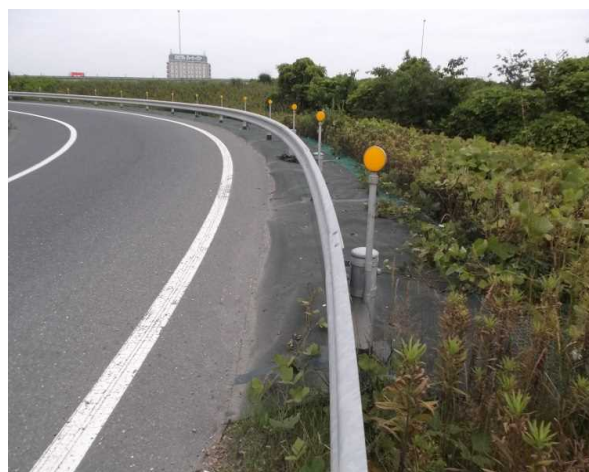
●視線誘導標新設
