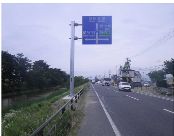
●案内標識新設
