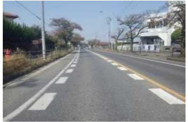
●減速路面標示例
