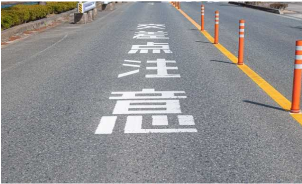
●交差点注意路面表示の施工例
