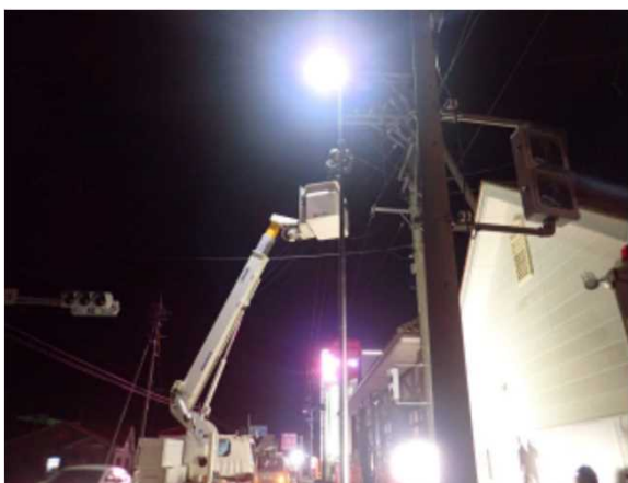
●照明灯更新（電源接続）
