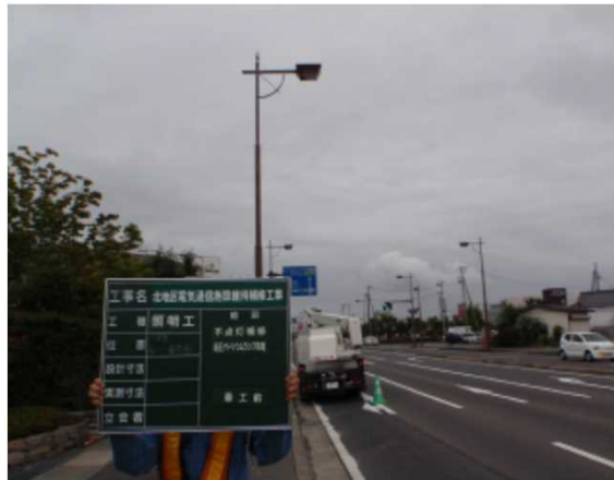
●不点灯補修（着工前）
