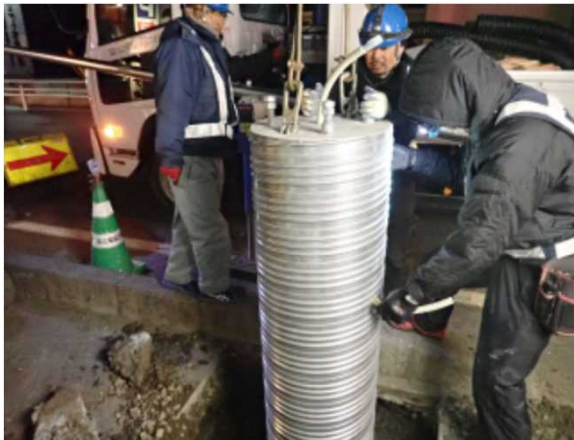
●照明灯更新（基礎設置）
