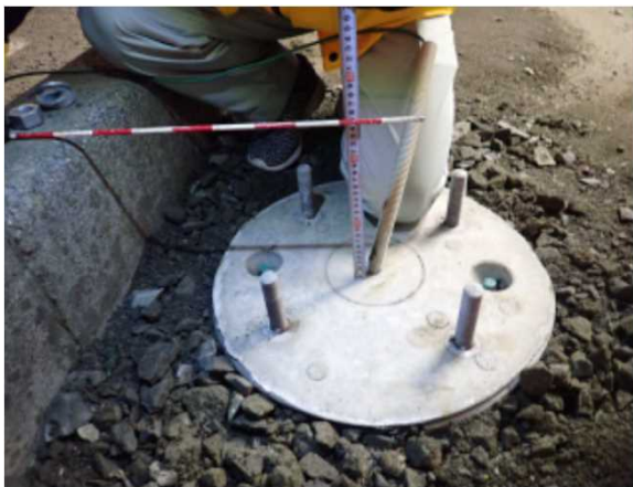
●照明灯更新（基礎設置）
