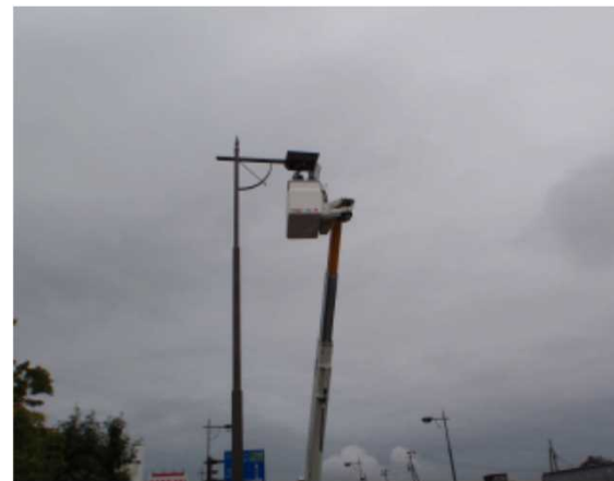
●不点灯補修（施工中）
