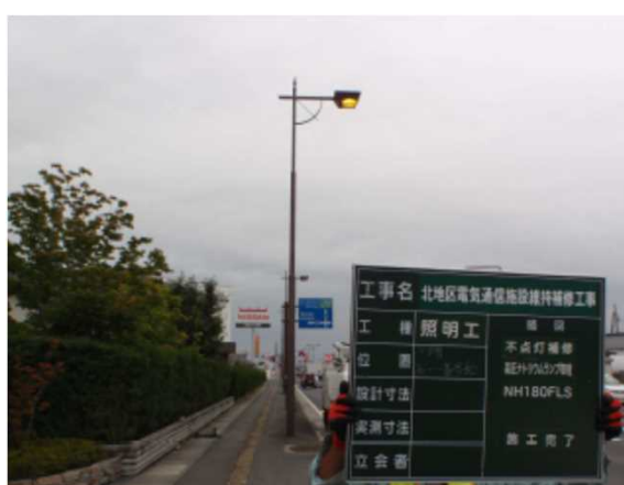
●不点灯補修（施工完了）
