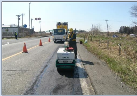
▲ 舗装(パッチング)
