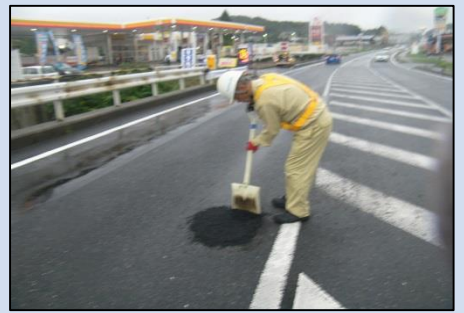
▲ 舗装の穴埋め
