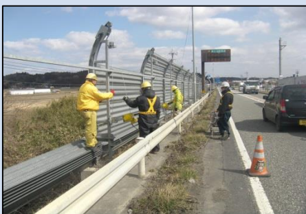
▲ 防雪柵の設置・撤去
