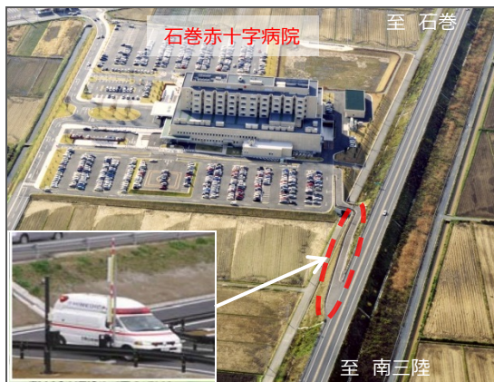
▲石巻赤十字病院に直結する救急車退出路
