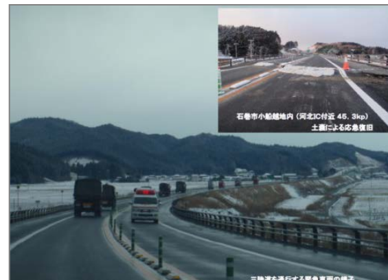
資料：仙台河川国道事務所「東日本大震災活動記録」 ▲三陸道を通行する緊急車両の様子 (登米市豊里町)
