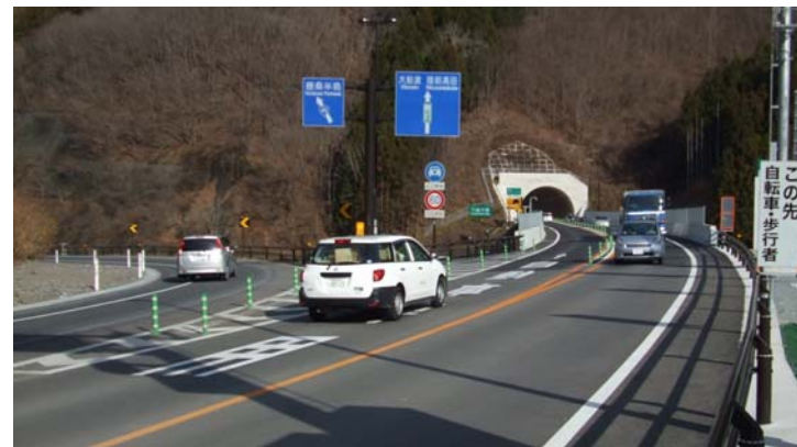
▲ 開通直後の唐桑道路(写真1)
