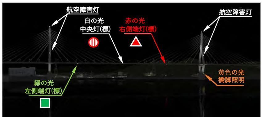
橋梁灯・橋梁標は航路の両端と中央の3箇所を設置していることによって、**船舶が安全に航行**できます。
