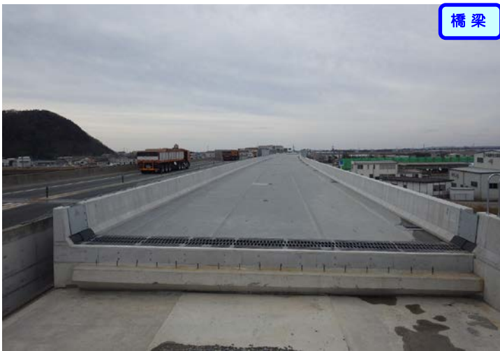
① 終点側から起点側を望む 曾波神高架橋
