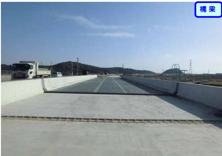
③ 終点側から起点側を望む 鹿又跨道橋
