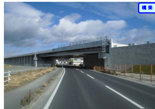
③ 起点側から終点側を望む 鹿又跨道橋
