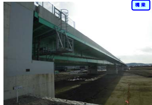
④ 終点側から起点側を望む 新天王橋
