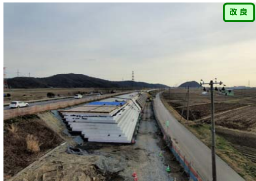
② No.110付近 終点側から起点側を望む
