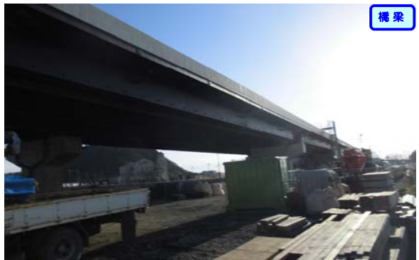
① 終点側から起点側を望む 曾波神高架橋
