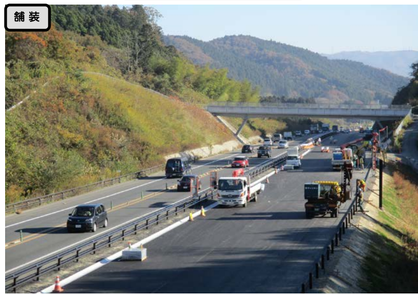
② No.440から起点側を望む
