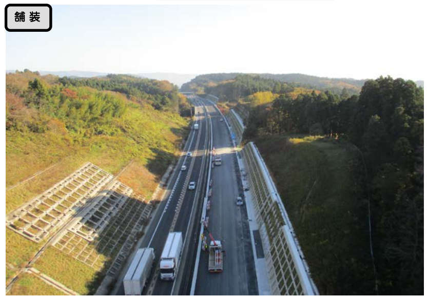
④ No.472から起点側を望む
