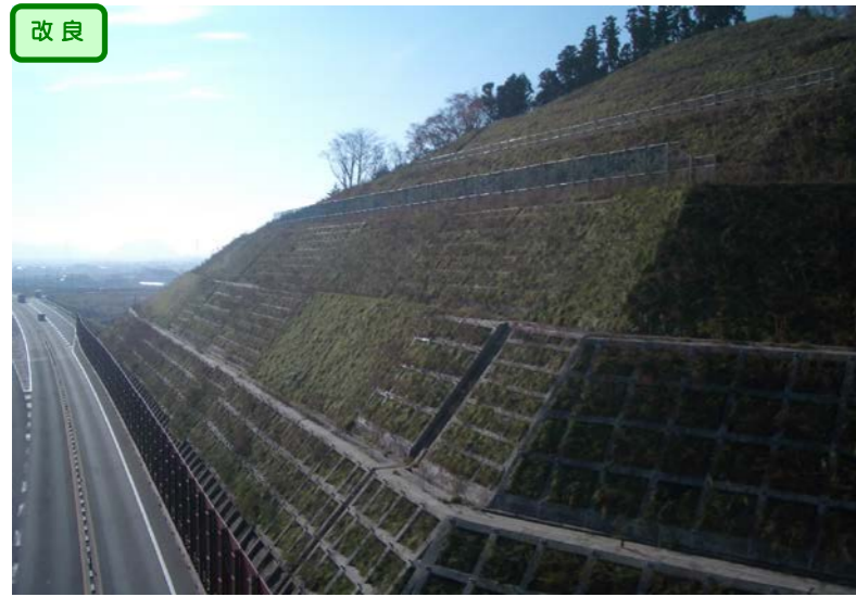
① No.215から起点側を望む
