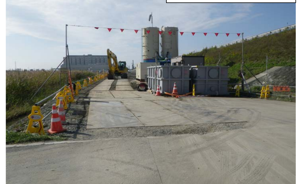
④ 終点側から起点側を望む
