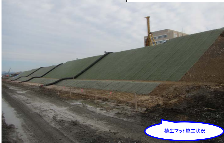
③ 起点側から終点側を望む
