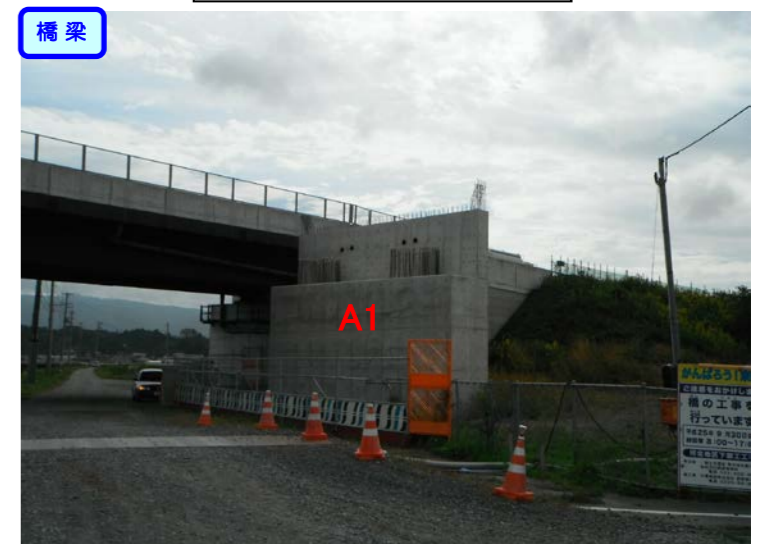
⑥ 左側からNo.317を望む 稲荷橋 橋台(A1)
