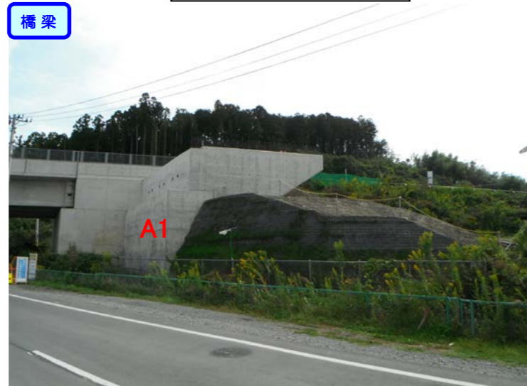
④ 左側からNo.236を望む 崎山橋 橋台(A1)
