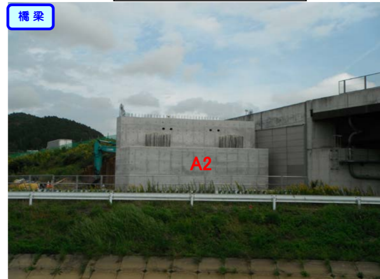
⑤ 起点側から終点側を望む 稲荷橋 橋台(A2)
