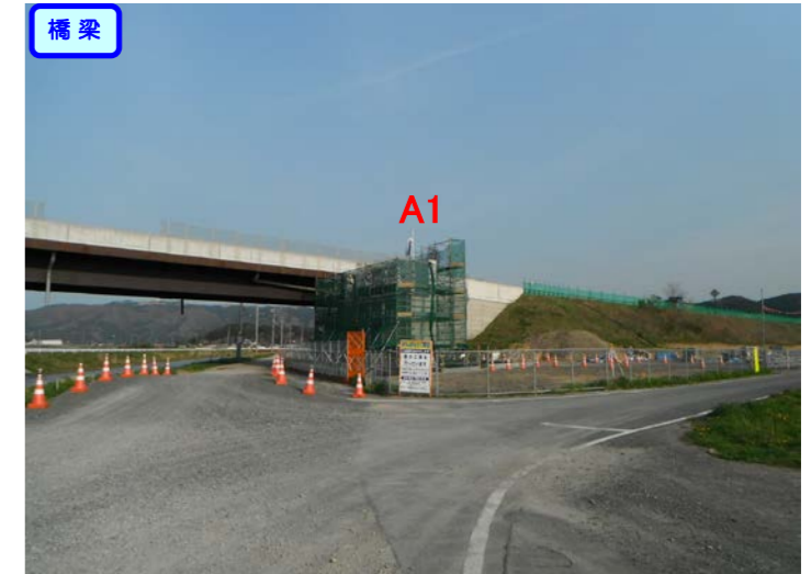
④ 左側からNo.317を望む 稲荷橋 橋台(A1)
