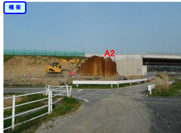
③ 左側からNo.317を望む 稲荷橋 橋台(A2)
