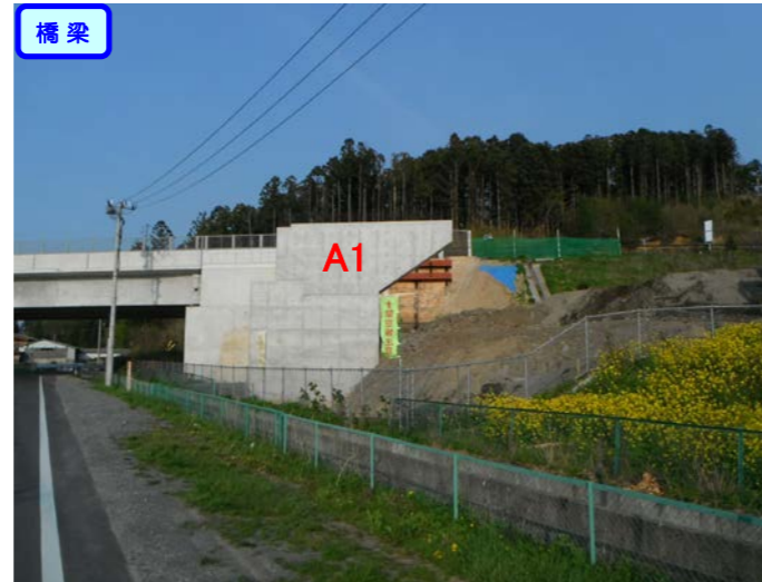
② 左側からNo.236を望む 崎山橋 橋台(A1)
